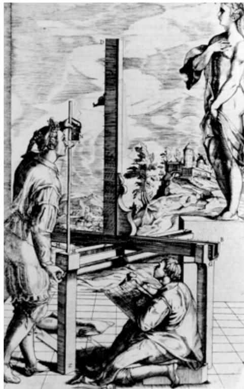
**Fig. 61. Máquina de perspectiva, diseñada por Jacopo Barozzi da Vignola, ca. 1583.**
