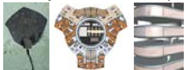
Fig superior 4.5.- Rascaeielos rotatorio de David Fisher para Moscú. Figs inferiores 4.6, 4.7 y 4.8.- Se observa la forma triangular de la manta raya y la de cada planta, además de los generadores eólicos ubicados entre cada piso.
