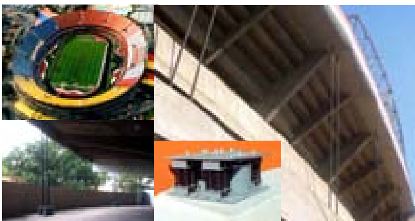
Fig. 8 (E.I.MEC.1). - Absorbedores dinámicos sintonizados en gradas para espectadores del Estadio de Fútbol Morumbi, Sao Paulo, Brasil.
