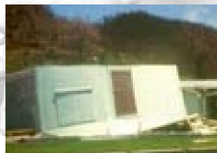
Fig. 20 (M.I.PRO.1). - Un edificio completo se volcó debido a la ausencia de anclajes o cimentación.
