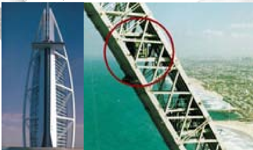
Fig. 5 (E.I.MEC.1). - En el único hotel de 7 estrellas del mundo, "Burj Al Arab" ubicado en Dubai, Emiratos Árabes Unidos, se instalaron varios absorbentes dinámicos sintonizados, para protegerlo de la fuerza del viento.
