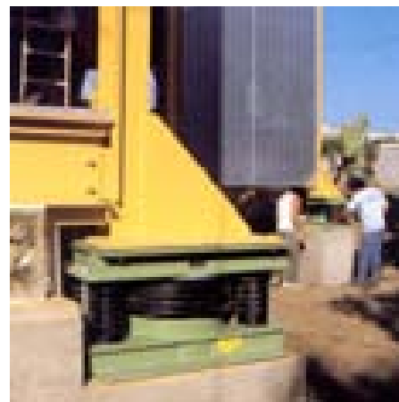
Fig. 4 (E.I.MEC.1). - Fotografía tomada durante la construcción de un edificio en Los Angeles, California con asentamientos elásticos.
