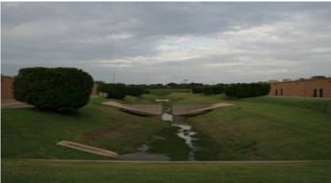
Corredor de usos múltiples pro recurso hidrológico destinado al encausamiento de escurrimientos interminentes en Dallas, Tx. U.S.A.
