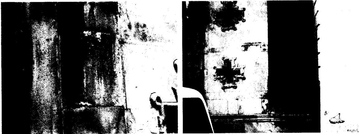
Imagen 2. Áreas de cantera con presencia de vegetación parásita. Fotografía tomada por: Arturo Fuentes M. 2006
