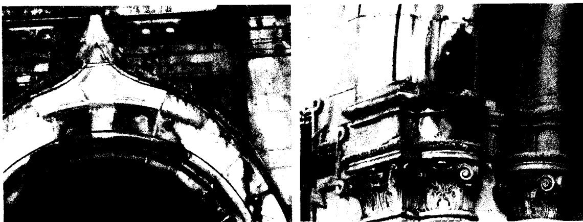
Imagen 1. Áreas de cantera con exfoliaciones. Fachada principal del templo. Fotografía tomada por: Arturo Fuentes M. 2006
