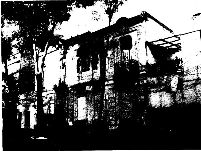
Imagen 9. Edificios abandonados que por su gran historia merecen ser rescatados.
