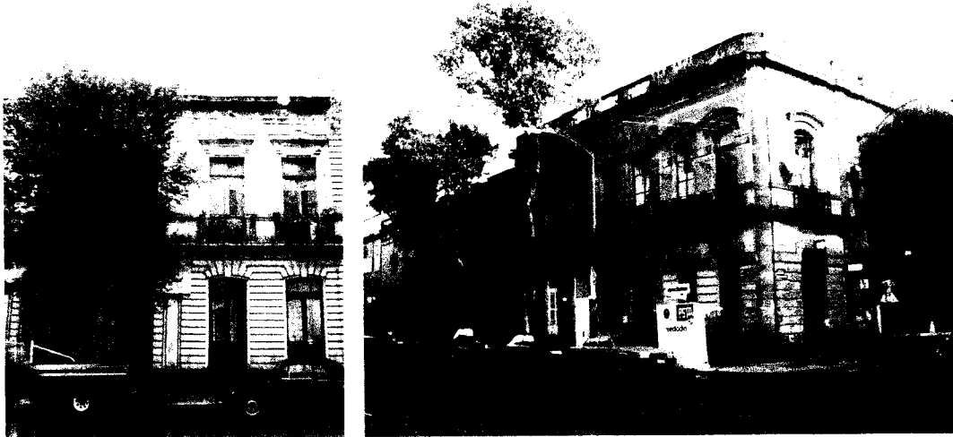
Imagen 12. Tipología característica en la colonia. Dignos ejemplos para su restauración y conservación. Ubicadas en las calles: Santa María No. 71 y Enrique González Martínez No. 25, 27. Fotografía tomada por: Arturo Fuentes M. 2007
