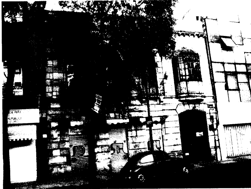
Imagen 10. Dignos edificios, ejemplos para restaurar y conservar en la Santa María la Ribera. Casa habitación ubicada en la calle Santa María No. 82 Fotografía tomada por: Arturo Fuentes M. 2007
