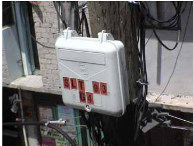
Figura III.3.4.b. Nodo de Servicio de Línea Telefónica en el segmento de dispersión.
