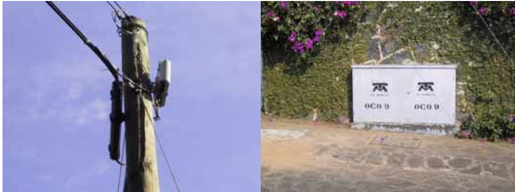
Figura III.3.d. Postes y Armarios utilizados en la red pública telefónica de Telmex.
