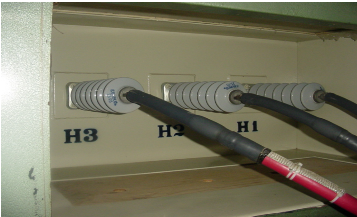
Figura II.2. Boquillas de un Transformador Trifásico Industrial
