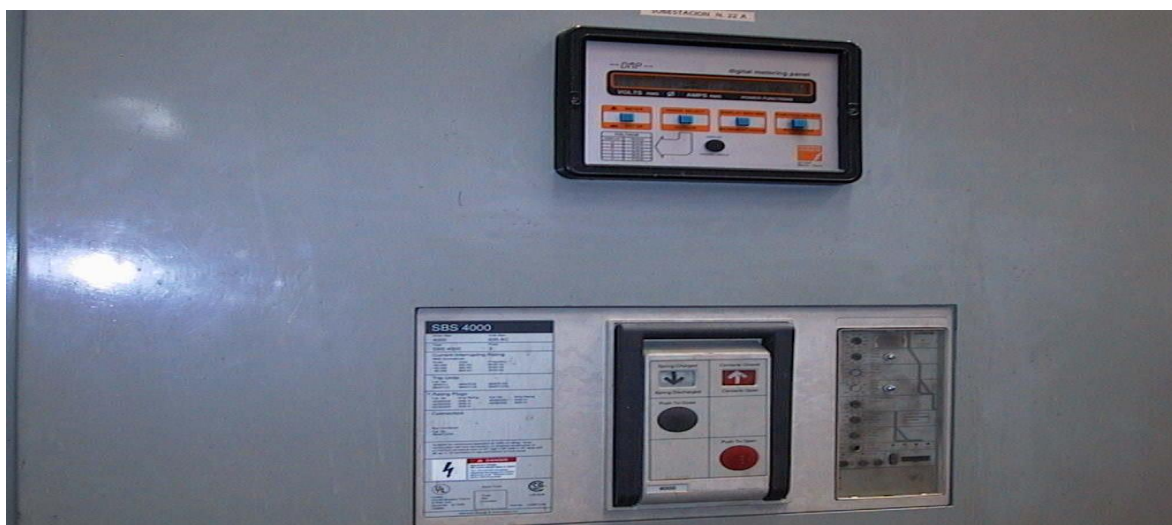
Figura II.10.- Vista frontal de la Sección de Medición Tipo Interior.
