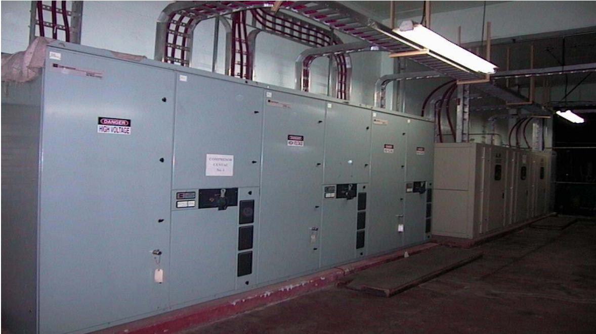
Figura I.5 Gabinetes de Subestación tipo compacta.
