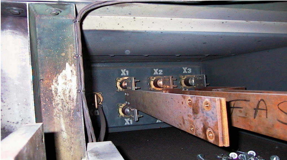
Fig. II.6.a.- Acoplamiento para Baja Tensión
