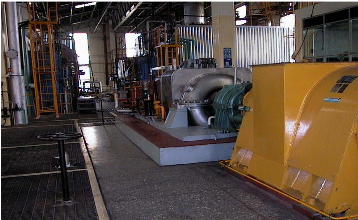
Figura I.1.- Turbo Generador Eléctrico de una Central Generadora.
