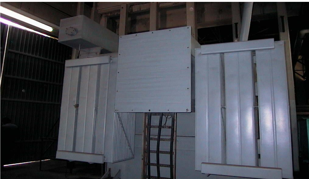
Fig. II.7.- Acoplamiento Para Alta Tensión y Bancos de Radiadores.
