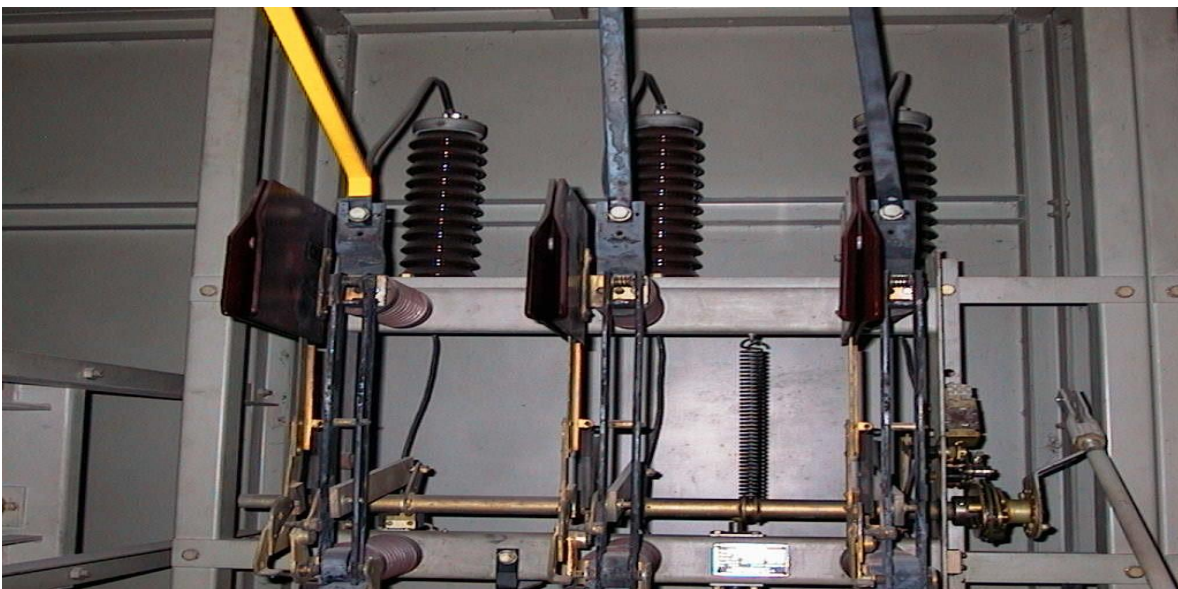
Figura II.11.b.- Vista de la Sección Cuchillas de Paso
