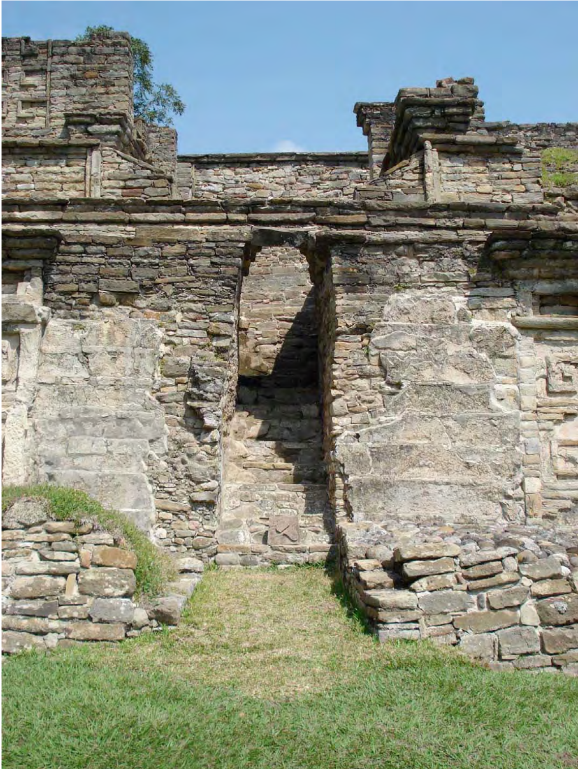
FIG. 143. Detalle de la escalera falsa del Edificio A del Tajín Chico (ca. 900 – 1100 d.C.). El Tajín, Veracruz. Foto: Raúl Rocha García (2008).
