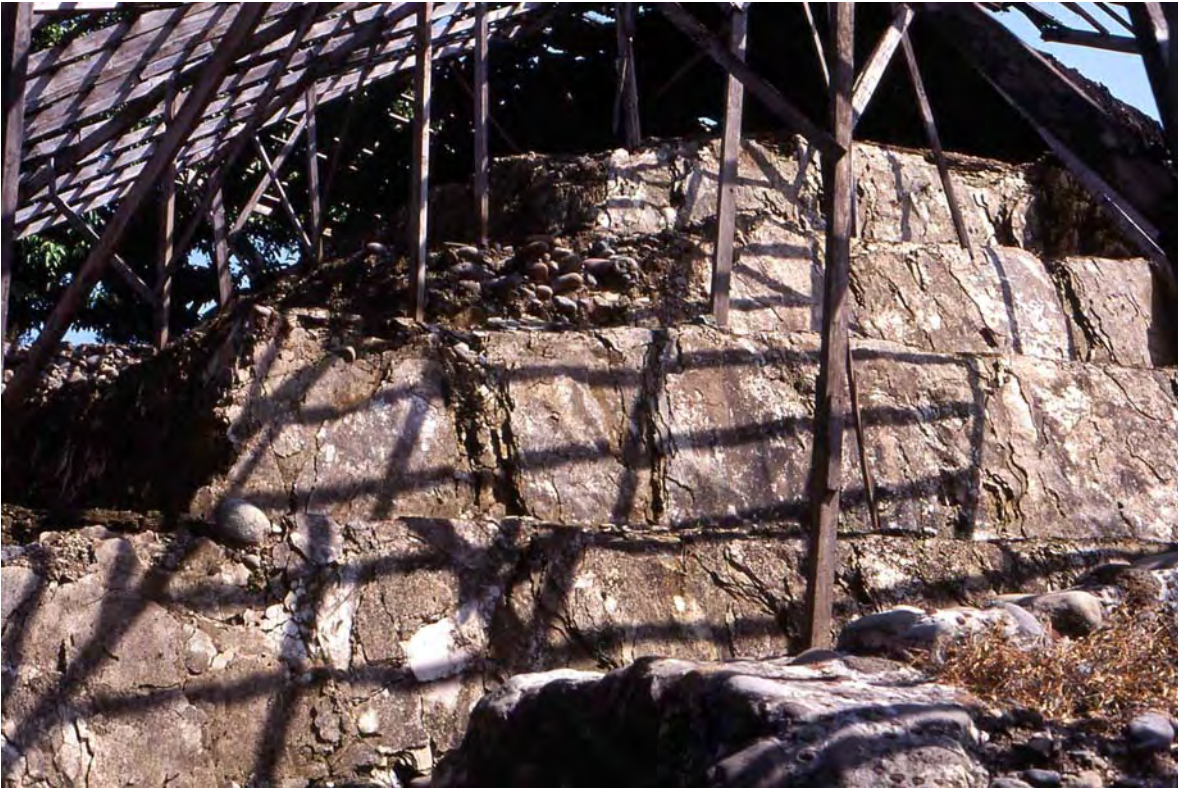
FIG. 154. El edificio de las pinturas (ca. 600 – 900 d.C.). Las Higueras, Veracruz. Foto: Arturo Pascual Soto (2004).
