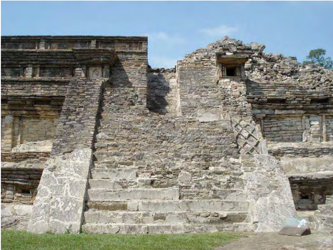
FIG. 144. Detalle de la escalera posterior del Edificio B del Tajín Chico (ca. 900 – 1100 d.C.). El Tajín, Veracruz. Foto: Raúl Rocha García (2008).
