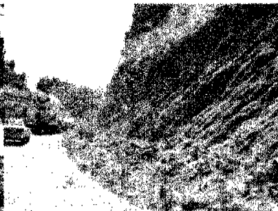
Vista encaucada por taludes.
