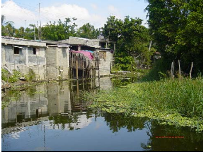
FIGURA 56. Asentamientos irregulares en los bordes del río Seco.
