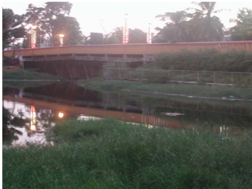
FIGURA 61. Puente de acceso a la ciudad de Paraíso
