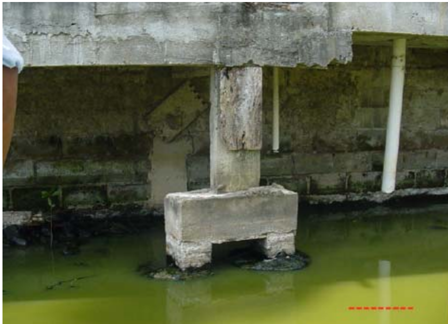
FIGURA 59. Invasión al cauce del río Seco.
