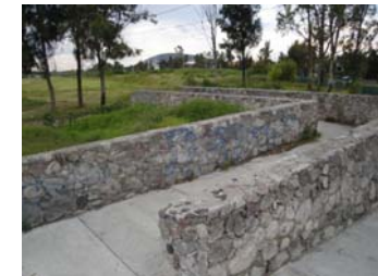
Fotografía 34. Acceso sureste. Rampa.
