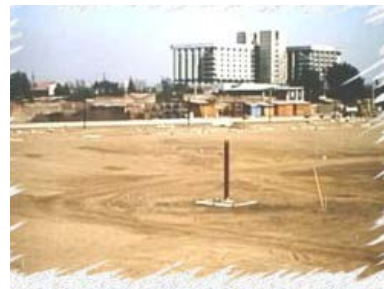
Fotografía 3. Al finalizar los trabajos de adaptación de relleno sanitario esta era la imagen Fotografía tomada de la página www.montealegre-beach-arquitectos.cl/html/obras_tx.htm
