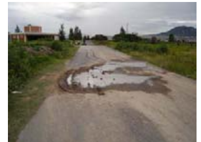
Fotografía 43. Andador principal de Este-Oeste. Sección sur-deportiva
