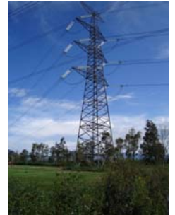
Fotografía 16. Torres de alta tensión ubicadas en el Eje 6 Sur
