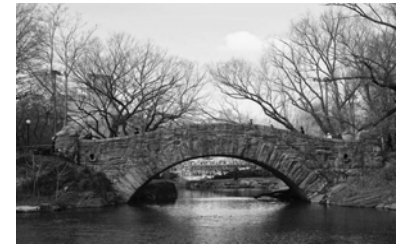
Fotografía 10. Puentes diseñados por Calvert Vaux. Central Park N.Y. Fotografía tomada de la pagina es.wikipedia.org/wiki/Central_Park
