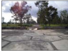
Acceso Avenida 8. Recibe al 10 % de los visitantes.
