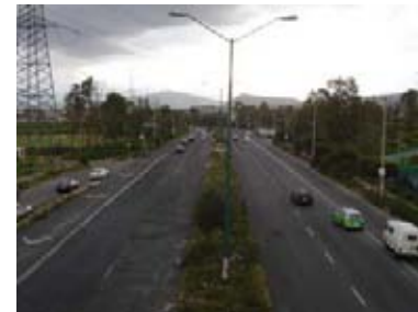
Fotografía 18. El Eje 6 sur Luis Méndez, es una vialidad muy importante para el parque
