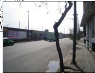
Calzada Ermita Iztapalapa. Borde importante visual y físico.
