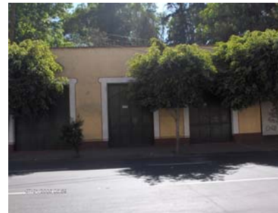
Colindancia lado derecho del terreno (vivienda)
