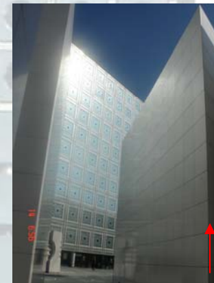
Acceso a Plaza Principal del Instituto del Mundo Árabe
