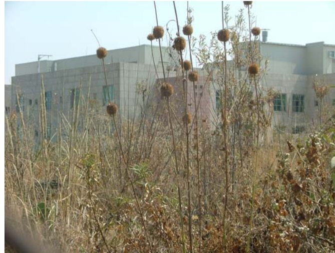
Vista del estado actual hacia la parte Sur del Terreno en donde se percibe la parte trasera del Hospital Shriners para niños.
