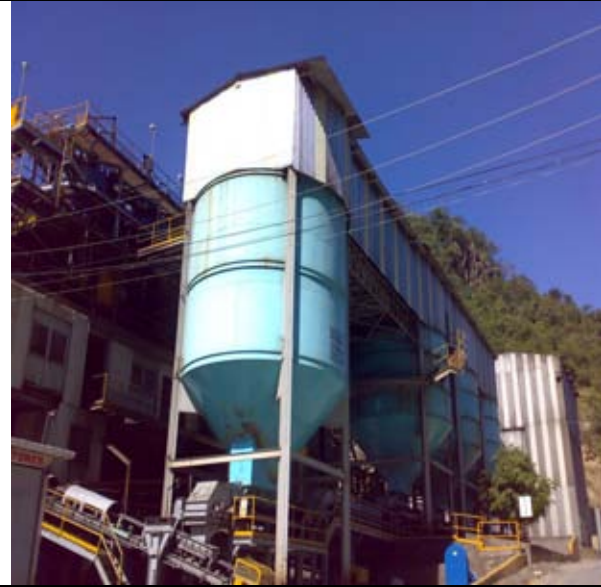
Foto 13. tolvas de minerales para molienda
