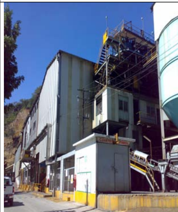
Foto 11. exterior de la planta del proceso de beneficio
