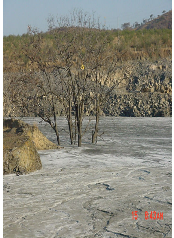
Foto 6. Presa de jales impacto de erosión a los alrededores
