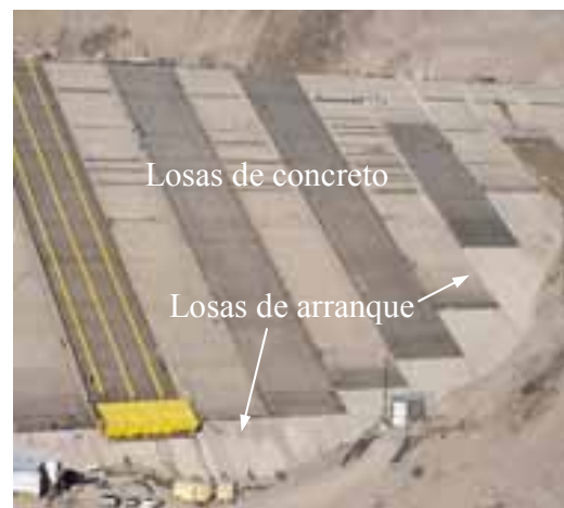
Fotografía 12. Colado de las losas de concreto
