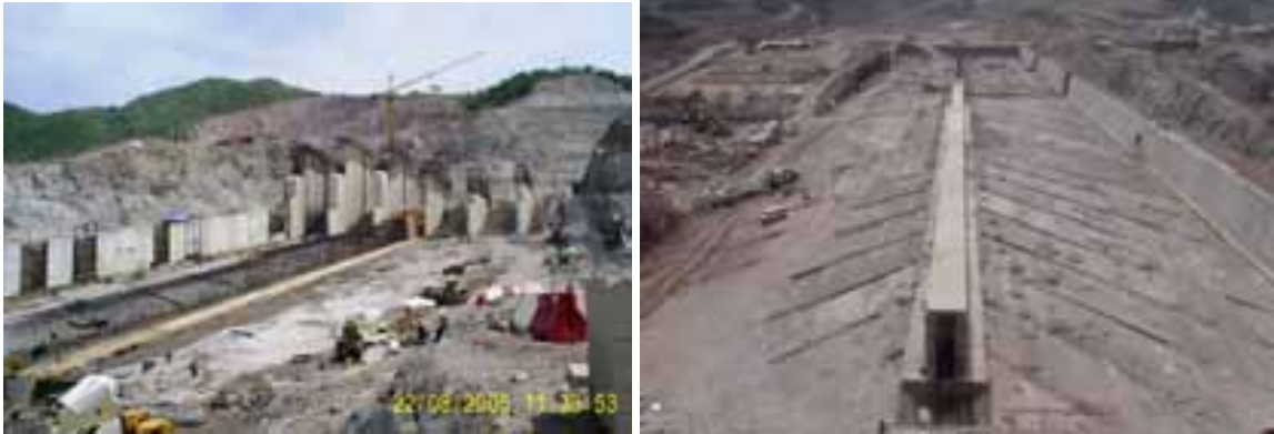
Fotografías 33 y 34. Avance en la construcción del muro divisorio (galería de inspección y drenaje) y muros laterales, vistos desde aguas abajo y aguas arriba.
