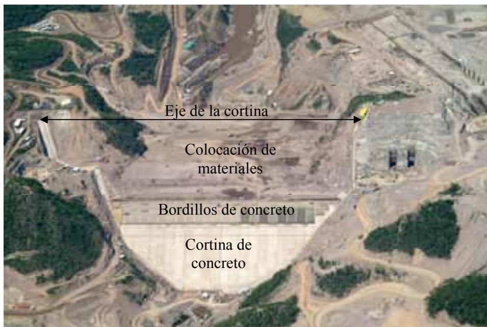
Fotografía 19. Vista panorámica de la cortina de concreto.
