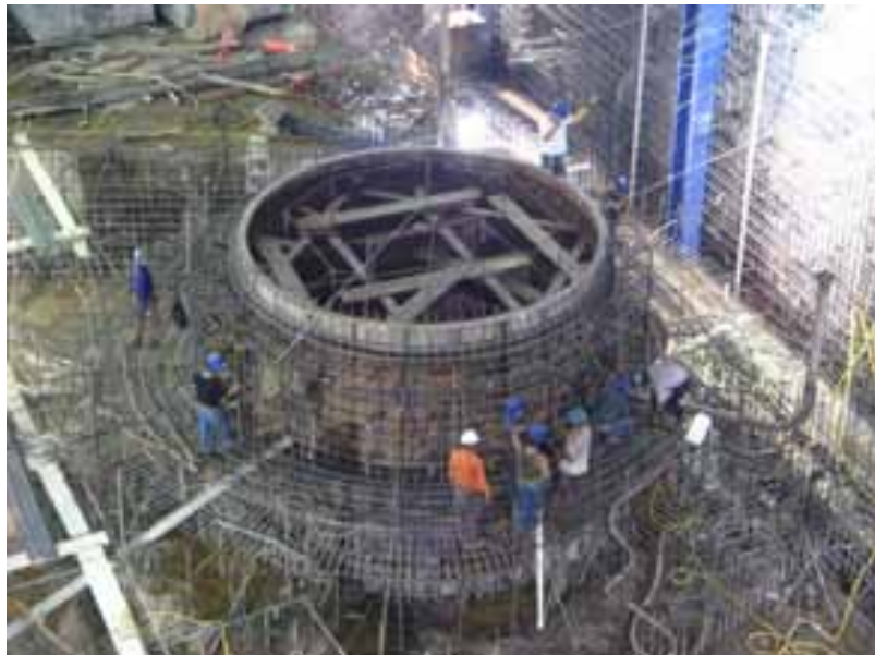
Fotografía 26. Colocación de varilla para el antedistribuidor de la unidad 2.
