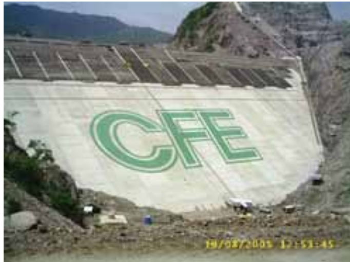
Fotografía 3. Primera etapa del colado de la cortina de concreto.
