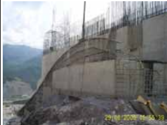
Fotografía 14. Vista aguas arriba de construcción del cimacio.
