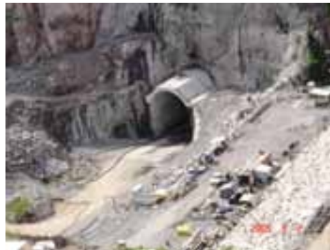
Fotografía 36. Corte ejecutado en taludes de ambas márgenes del túnel de desfogue.
