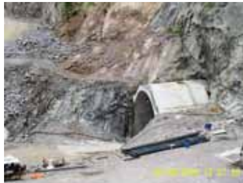
Fotografía 35. Vista aguas abajo del portal de salida del túnel de desfogue.
