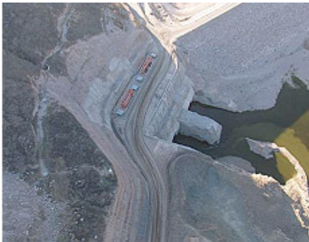
Fotografía 1. Túnel de desvío 1 y 2 ( Portal de entrada).
