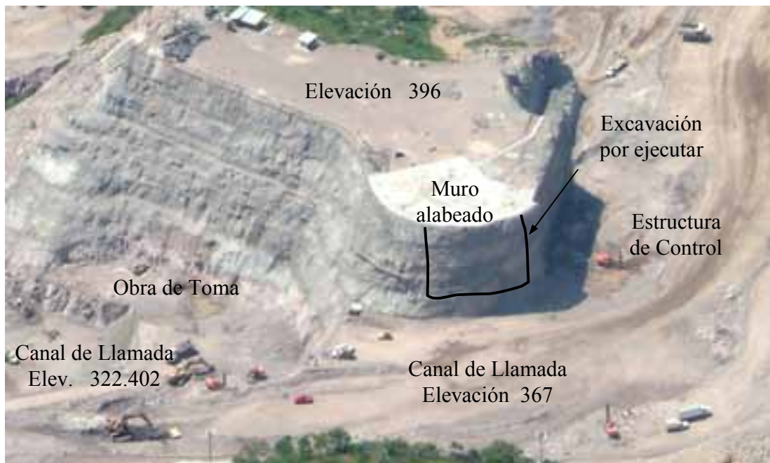
Fotografía 5. Excavación por ejecutar una parte del muro alabeado.
