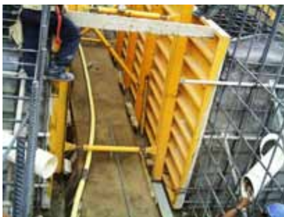
Fotografía 28. Colocación de tubos pvc en el muro divisorio de la galería de inspección y drenaje.
