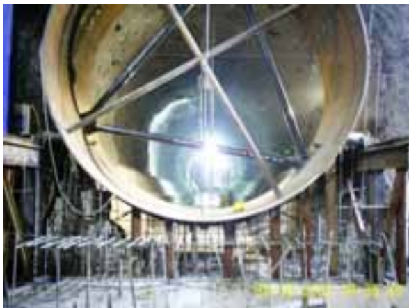
Fotografía 20. Colocación del primer canuto. Vista del canuto desde casa de máquinas.
