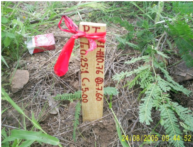
Fotografía 3. Talud y corte del punto PT de la curva horizontal.
