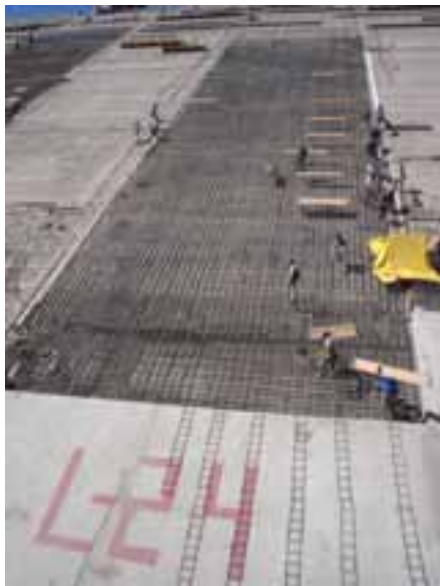
Fotografías 13 y 14. Armado de acero de refuerzo en la losa 24, en la figura opuesta se aprecian los avances en la colocación del acero de refuerzo en las losas 22, 26 y 28.
