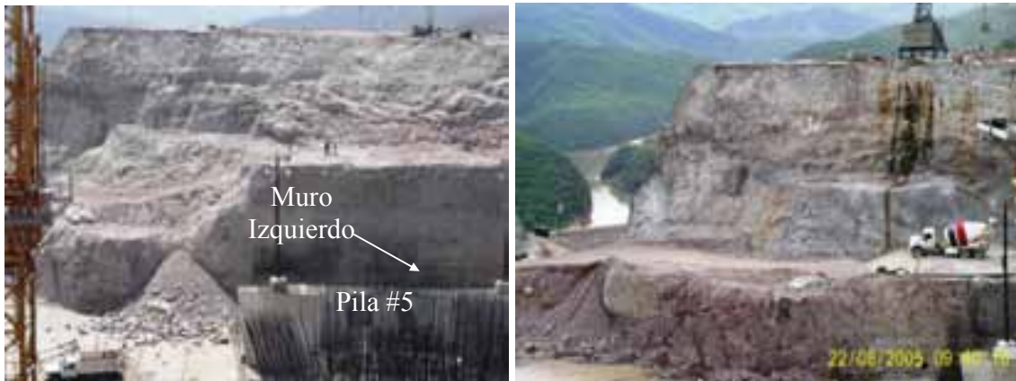
Fotografías 6 y 7. Excavación ejecutada para evitar colapso súbito.
