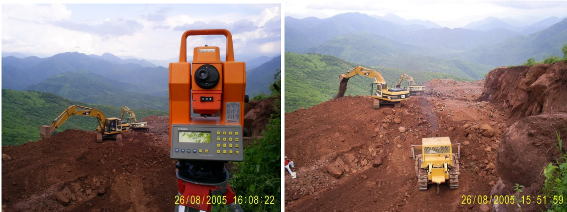
Fotografías 6 y 7. Ejecución de los trabajos de terracerías con maquinaria pesada.
