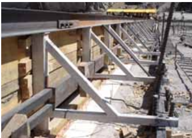
Fotografía 15. Colocación y nivelación de las escuadras de acero para el soporte de los rieles.
