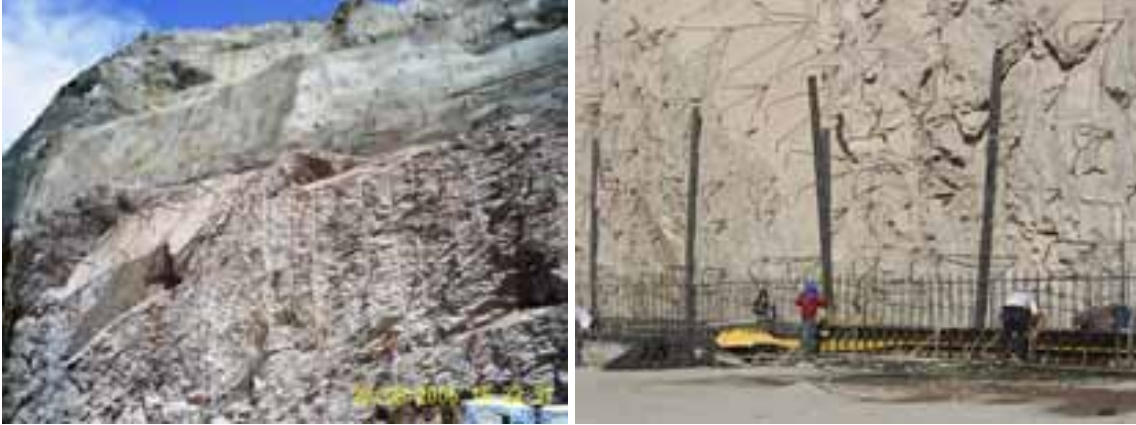
Fotografías 23 y 24. Colocación de anclas en la margen izquierda del vertedor.
