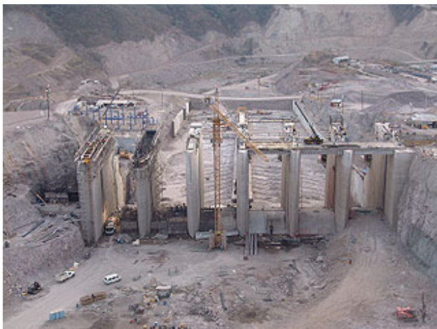
Fotografías 24 y 25. Avance de la estructura de control. Vista del colado de la cresta del cimacio.
