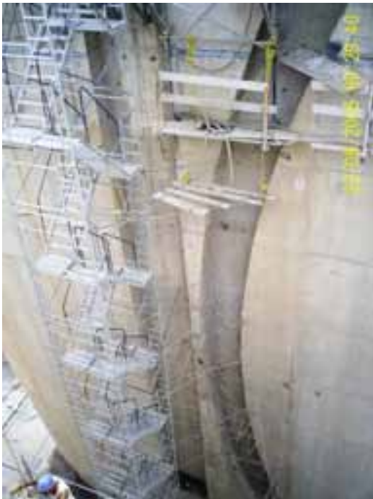
Fotografía 21. Ranuras para compuerta radial y plana.
