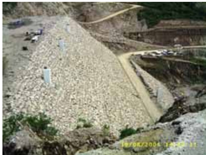
Fotografía 4. Cortina de roca (enrocamiento) aguas abajo.
