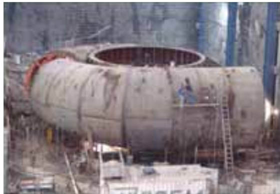
Fotografía 29. Montaje de la carcasa de la unidad 2.
