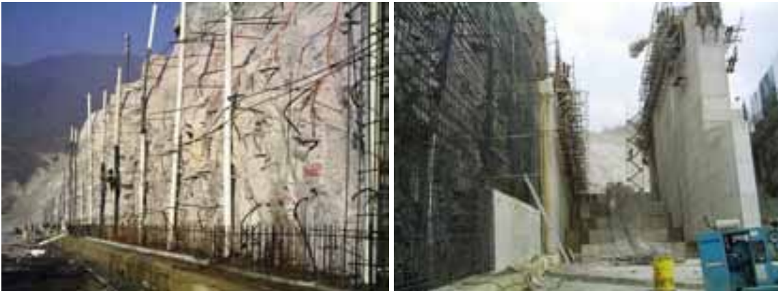
Fotografías 25 y 26. Colado concreto – roca del muro derecho del vertedor.
