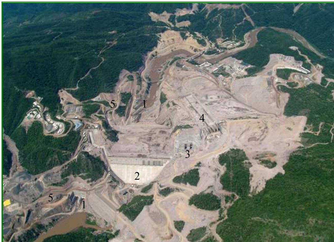
Fotografía 4. Vista del avance de la presa El Cajón hasta Agosto de 2005.
