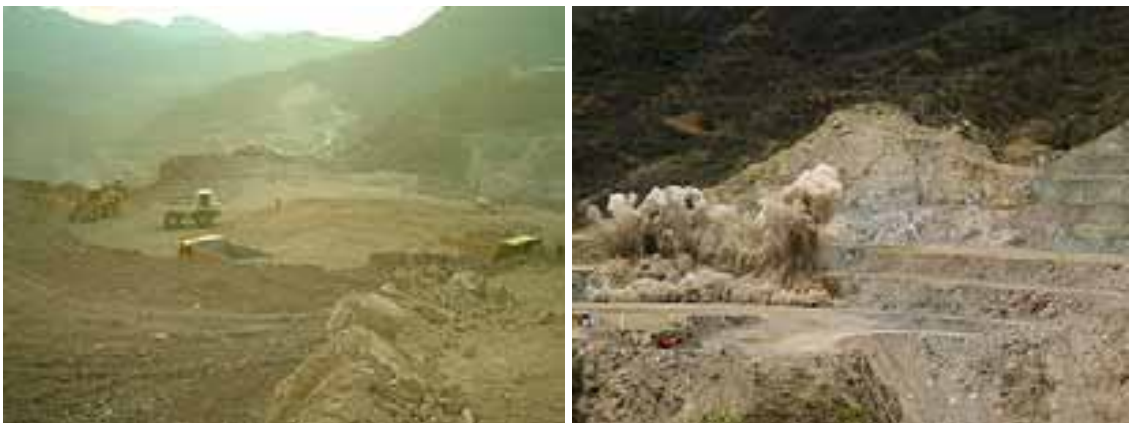
Fotografías 1 y 2. Excavación del canal de llamada en obras de excedencias.
