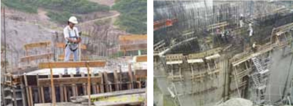
Fotografías 19 y 20. Vista aguas arriba de la pila #3 antes de colar.
