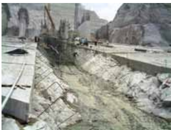
Fotografía 29. Desplante del muro divisorio.
