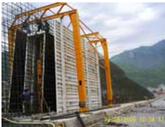
Fotografía 32. Colocación de cimbra metálica.
