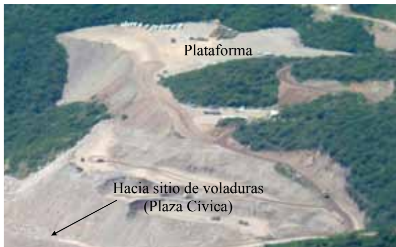
Fotografía 8. Vista panorámica de la plataforma.
