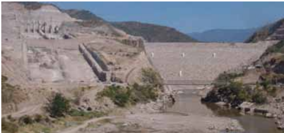
Fotografía 35. Vista aguas abajo de la obra de excedencias y de la cortina de roca.
