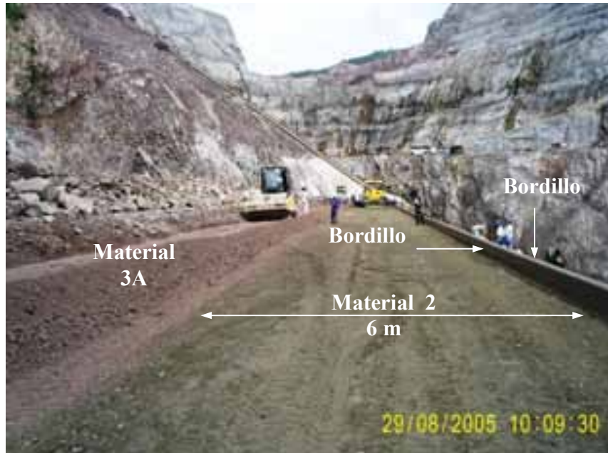
Fotografía 7. Distribución de materiales en la cortina.
