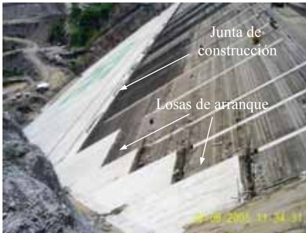
Fotografía 11. Losas de arranque en la margen derecha.
