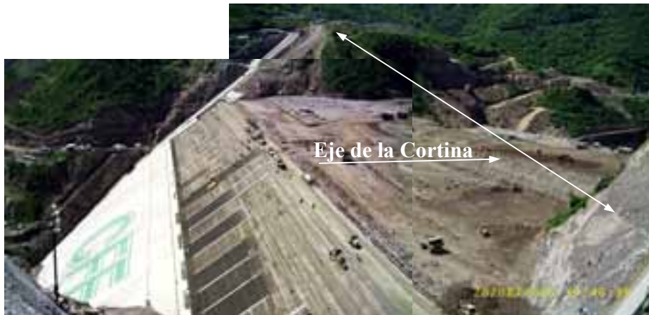
Fotografía 11. Vista general del colado de la cortina (1° etapa) talud aguas arriba, y de la colocación de bordillos y materiales diversos a la elevación 310 msnm.
