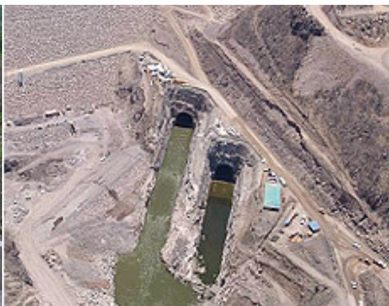
Fotografías 2 y 3. Túnel de desvío 1 y 2 ( Portal de salida).
