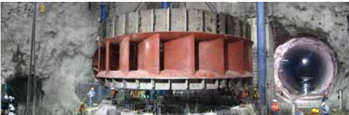
Fotografía 28. Vista del antedistribuidor de la carcasa de la unidad 2 y de la tubería a presión 2.
