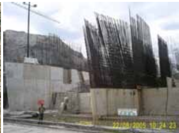
Fotografía 12. Desplante de acero de refuerzo. Fotografía 13. Vista aguas arriba de construcción de la pila.
