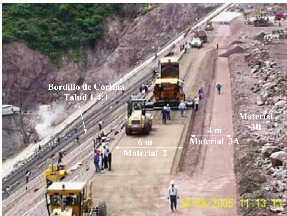
Fotografía 10. Colocación de material 2 hacia la margen izquierda de la cortina.
