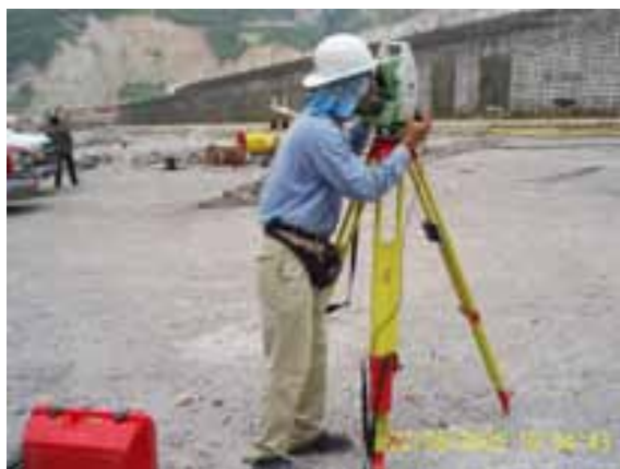
Fotografía 31. Punto de apoyo en canal de descarga.
