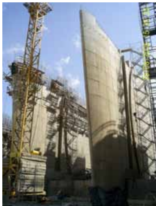
Fotografía 22. Vista aguas arriba de la pila 1 y 2.
