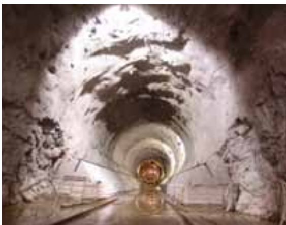
Fotografía 4. Tubería a presión no. 1, codo inferior y rama horizontal.
