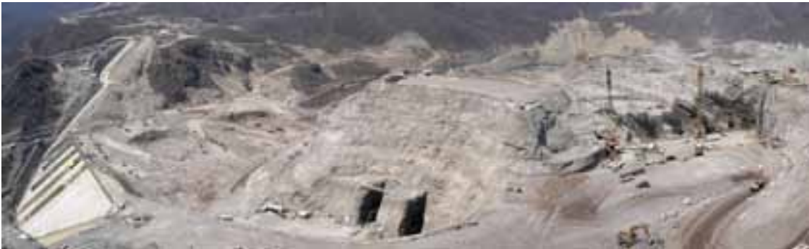
Fotografía 23. Vista panorámica de la obra de contención - obra de toma -obra de excedencias.
