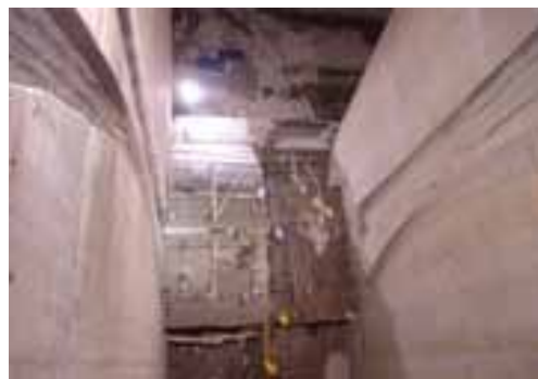
Fotografías 24 y 25. Avance de la estructura de control. Vista del colado de la cresta del cimacio.
