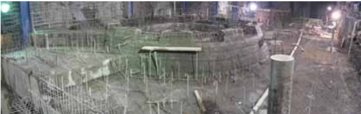
Fotografía 27. Vista de los acabados en concreto del piso de la galería intermedia y de la base del antedistribuidor de la unidad 2 de casa de máquinas.
