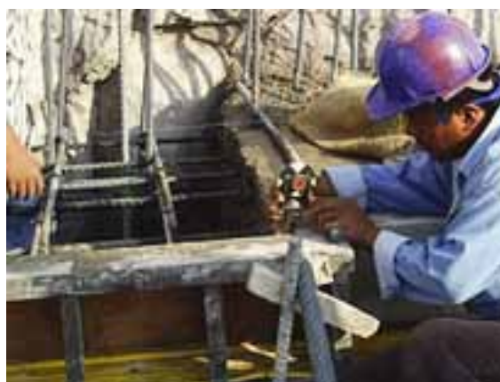
Fotografía 30. Chequeo de la cimbra para el colado.
