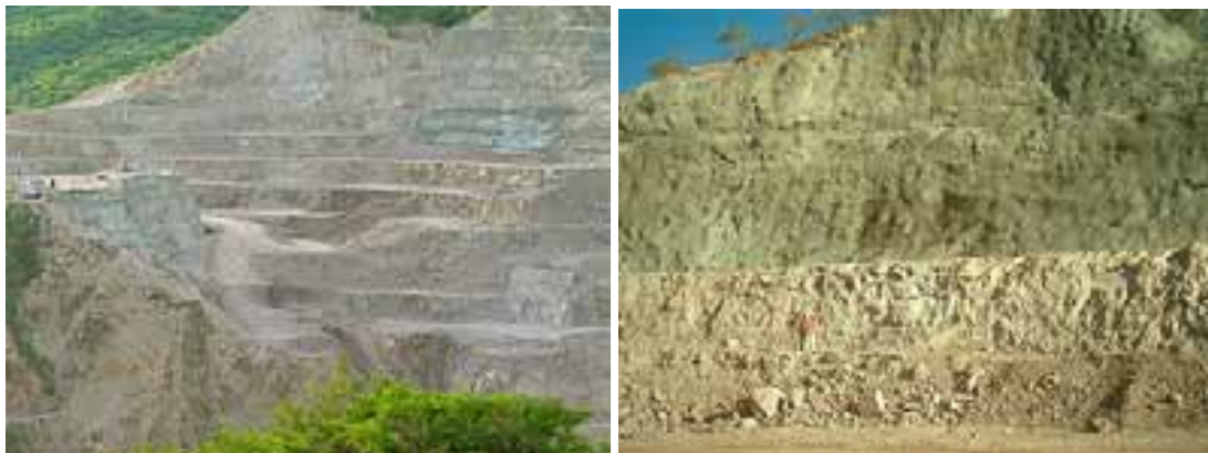
Fotografías 3 y 4. Tratamiento en talud y bermas en loma oriente del Canal de llamadas.
