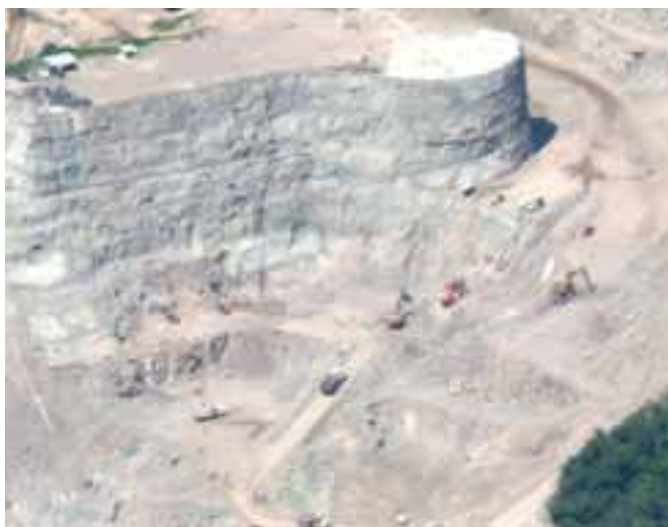
Fotografía 9. Excavación de las bermas y del canal de llamada de la obra de toma.
