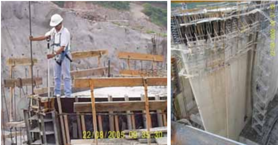
Fotografías 15 y16. Vista aguas arriba de la pila 1. Cadenero colocando el bastón con prisma en la punta de la nariz de la misma pila para el chequeo de la cimbra para el colado.
