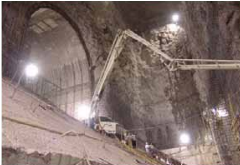
Fotografía 8. Galería de oscilación, arriba se observa el portal de entrada del túnel de desfogue.
