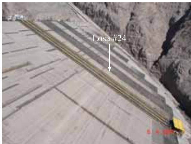
Fotografías 13 y 14. Armado de acero de refuerzo en la losa 24, en la figura opuesta se aprecian los avances en la colocación del acero de refuerzo en las losas 22, 26 y 28.
