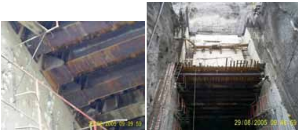
Fotografías 13 y 14. Ménsulas de acero para la colocación de vigas del mismo material.
