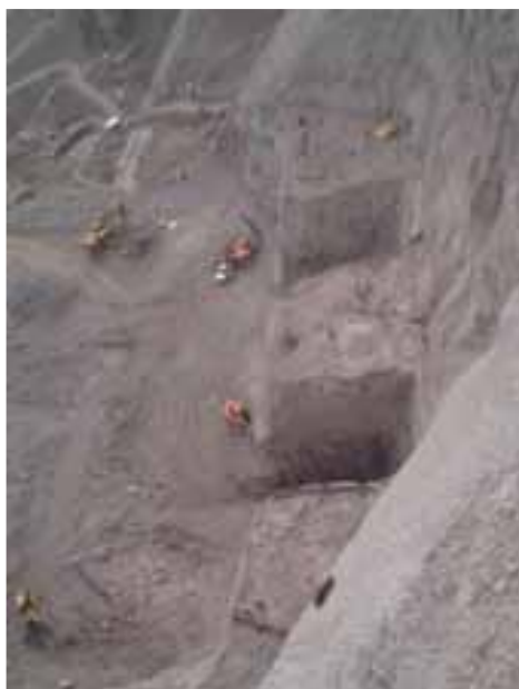
Fotografía 10. Excavación de las bocatomas de las unidades 1 y 2.
