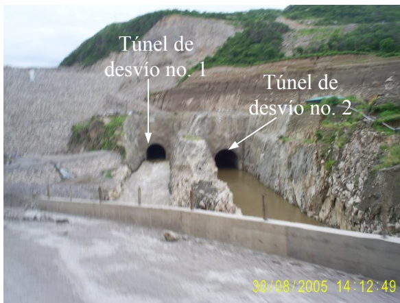
Fotografías 2 y 3. Túnel de desvío 1 y 2 ( Portal de salida).
