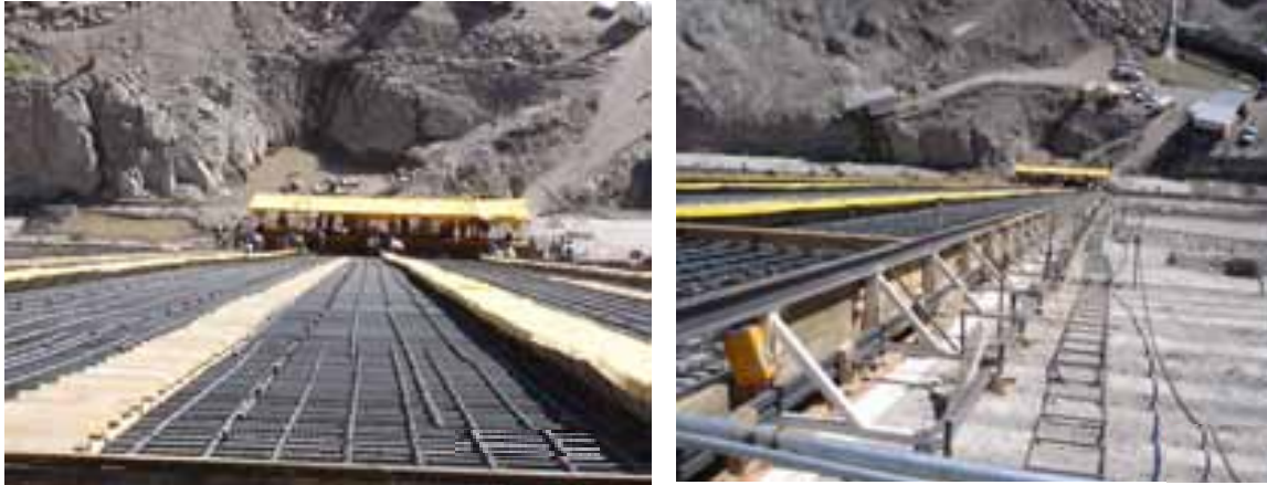
Fotografías 17 y 18. Maniobras para la colocación de la cimbra deslizante y trabajos preliminares para el colado de la losa 24 en la cara de concreto.
