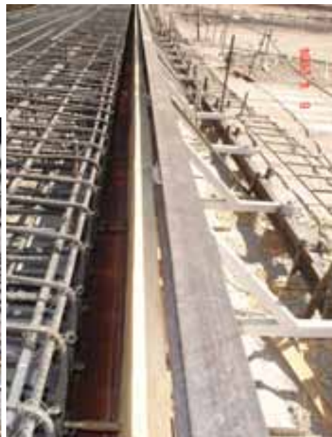
Fotografía 16. Junta compuesta por un sello de cobre.
