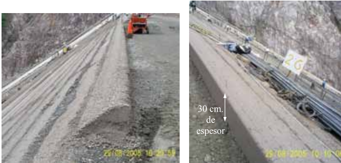
Fotografías 5 y 6. Bordillos de cortina de concreto extruido talud aguas arriba.
