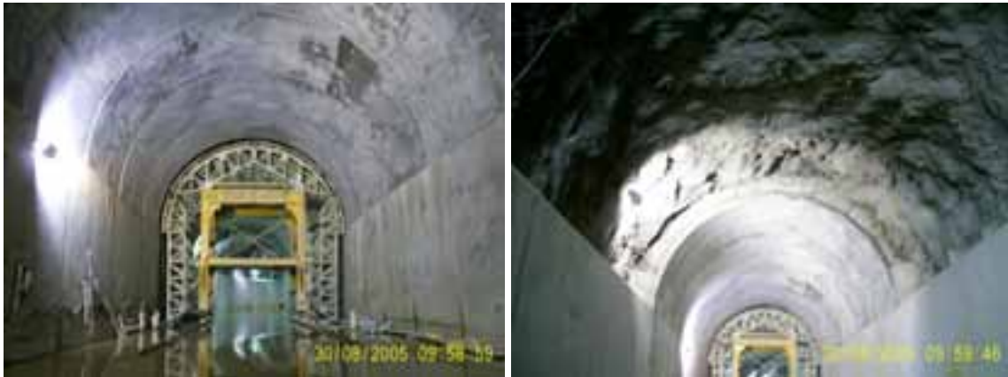
Fotografías 31 y32. Maniobras para la colocación de la cimbra y trabajos preliminares para el colado.
