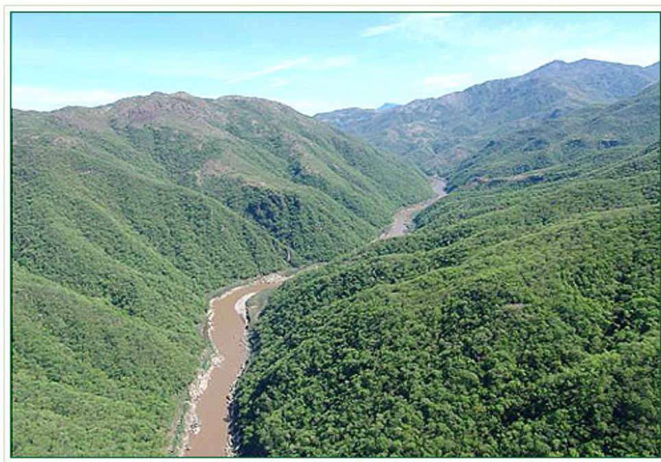
Fotografía 1. Vista parcial del área que abarcará la presa El Cajón
