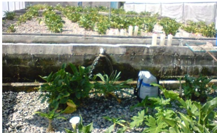
Figura 6. El muestreo en el módulo II se realizó en la salida, se recolectó agua tratada, del módulo de pulimento.
