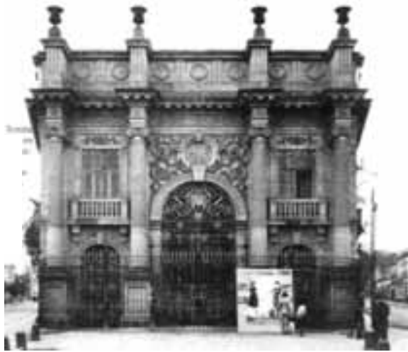
Casa de los Mier y Celis, desaparecida en la década de 1920, para dar paso al edificio Ermita. Fotografía Manuel Ramos publicada en Centro, 2006.
