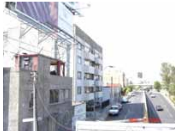
Foto 8. Vista del Viaducto hacia el poniente (Periférico)
