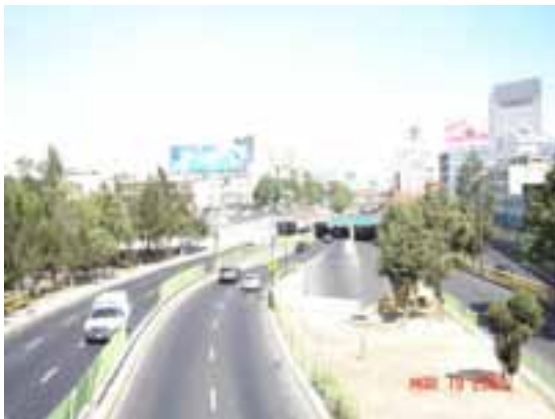
Foto 7. Vista del Viaducto hacia el oriente
