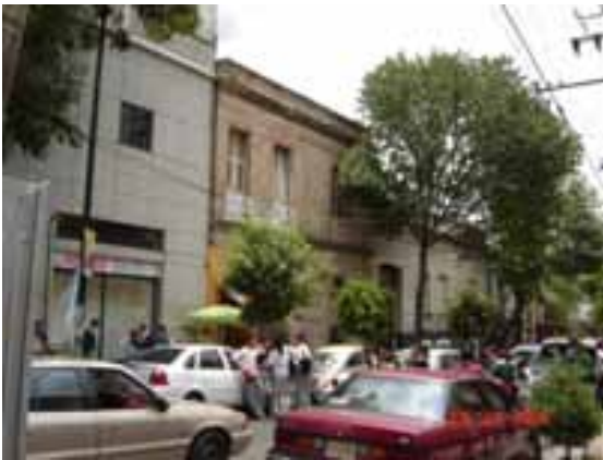
Vista de una calle de la col. Escandón donde puede apreciarse el abandono en el que se encuentra un edificio antiguo, el contraste entre este con una construcción más moderna y la mezcla de uso habitacional con comercio
