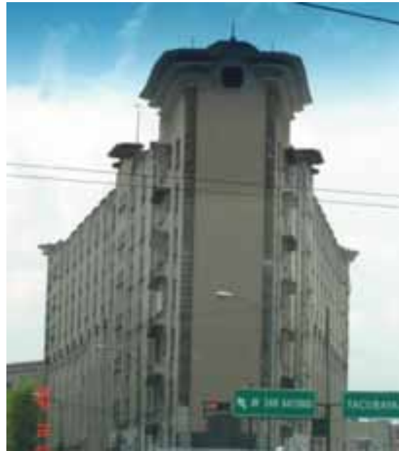
Edificio Ermita de Juan Segura col. Tacubaya
