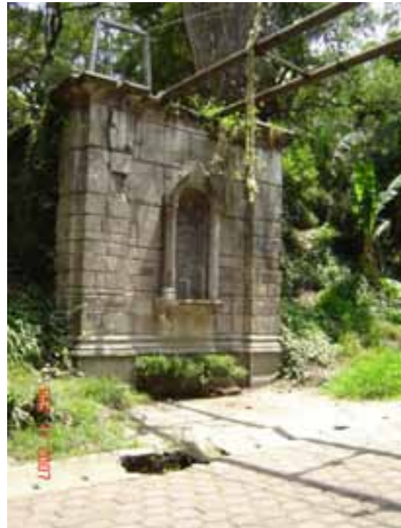
En esta imagen se observa una construcción antigua que servía de apoyo a un puente. Algunos de estos elementos tenían nichos en los cuales actualmente se colocan imágenes de Santos.
