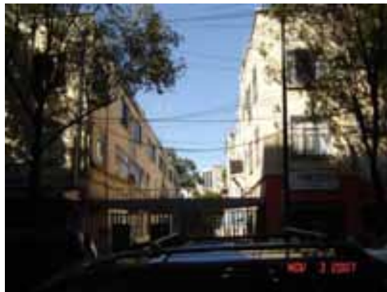
Aspecto actual del Edificio.
