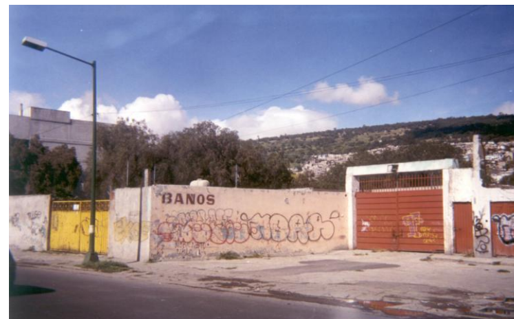
F11 / VISTA FRENTE DEL TERRENO-AV. CENTENARIO
