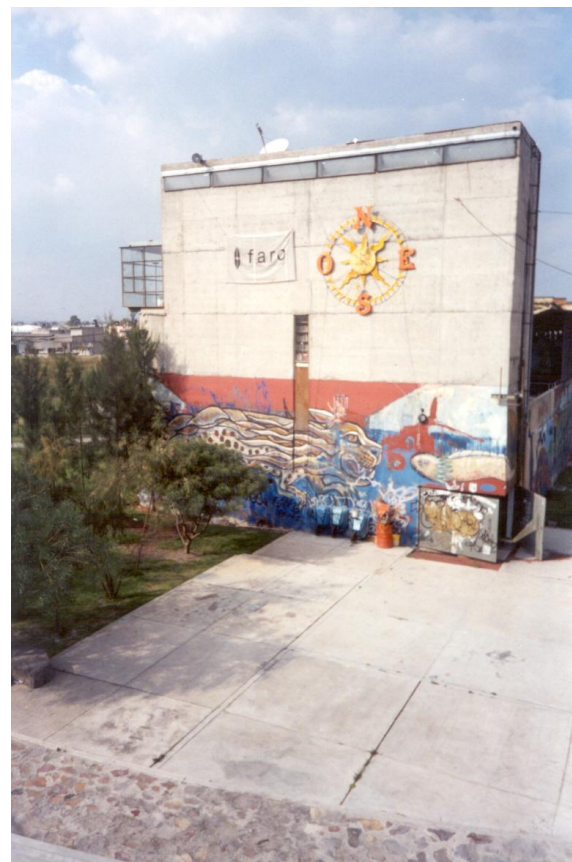
FACHADA VISTA POR AV. IGNACIO ZARAGOZA
