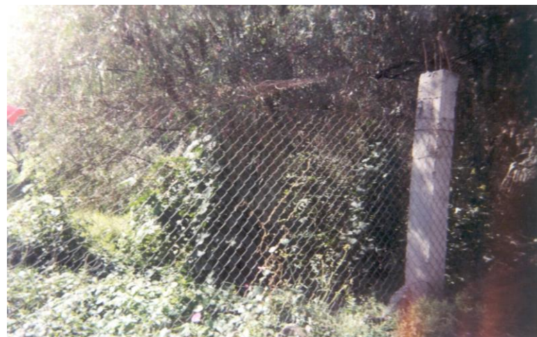
F23 / VISTA DEL TERRENO-CALLE CABO FINISTERRE
