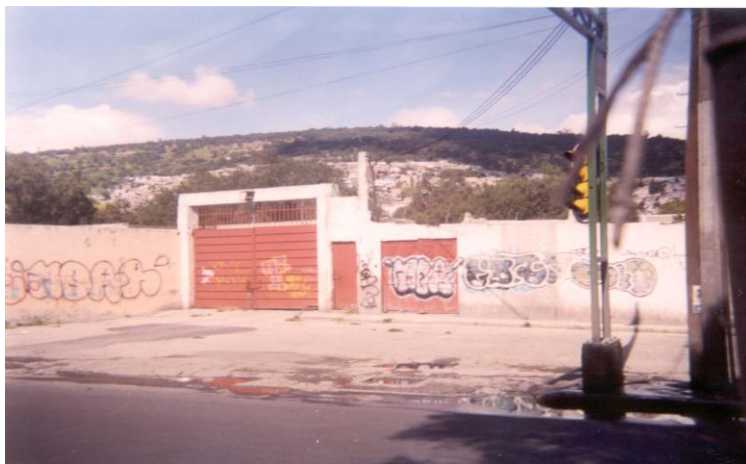
F9 / VISTA FRENTE DEL TERRENO-AV. CENTENARIO
