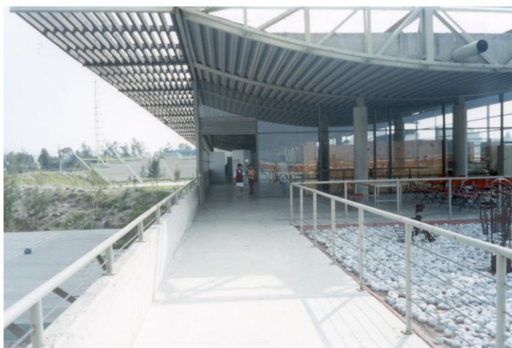
F2 / ACCESO LADO NORTE POR PLANTA ALTA.
