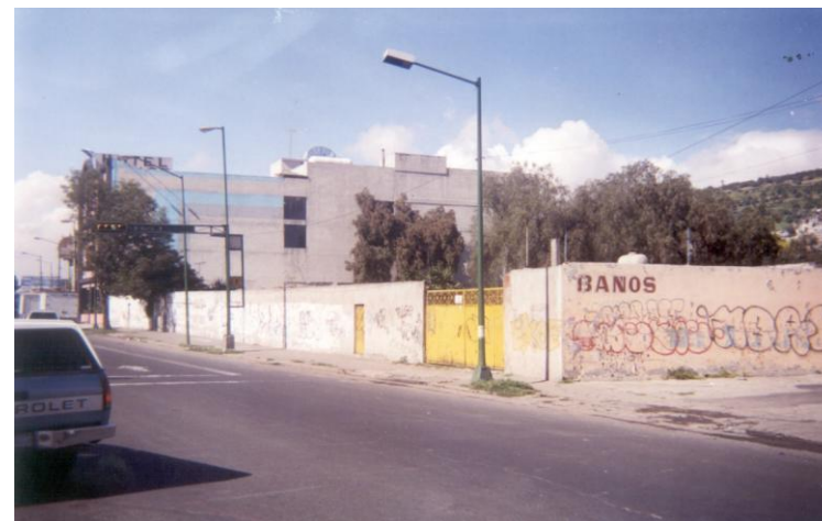
F15 / VISTA FRENTE DEL TERRENO-AV. CENTENARIO
