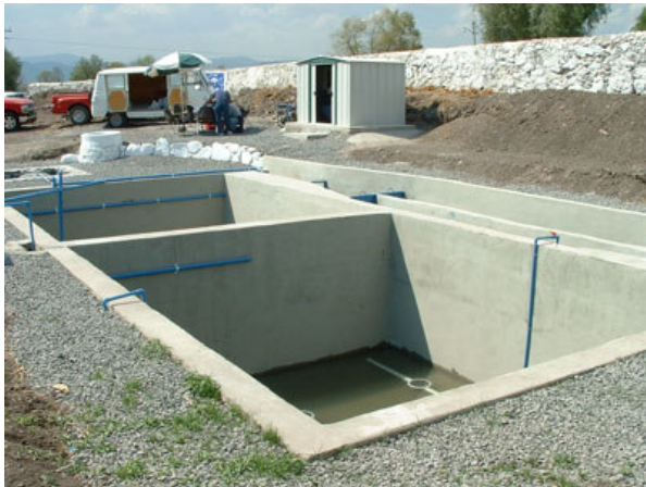
Construcción de casetas de concreto armado
