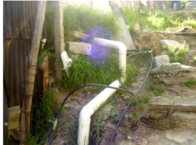
Tubería de PVC para conexión de Drenaje
