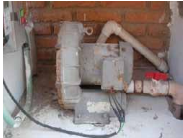
Foto 4.- Soplador de 2 HP con el que se abastecía a los estanques de cultivo
