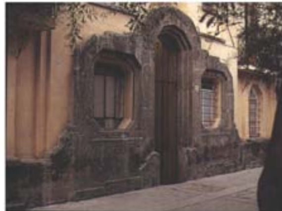
Acceso a inmueble con marcado trazo geométrico estilo Art déco en la calle de Puebla # 82
