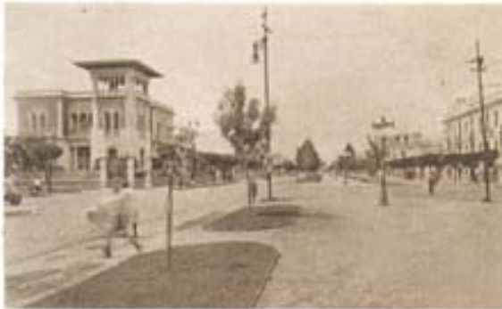
Av. Jalisco en su cruce con la calle de Orizaba.
