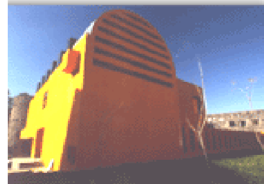
Fachada la Esmeralda
