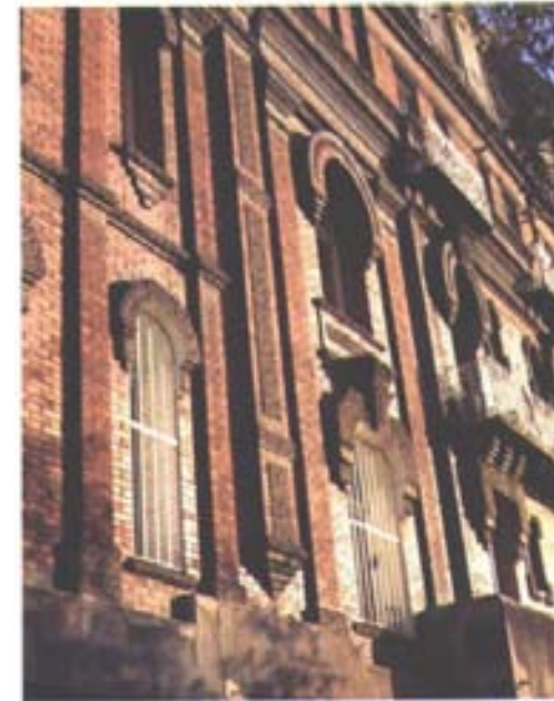
Fachada del edificio Río de Janeiro, antes edificio Roma
