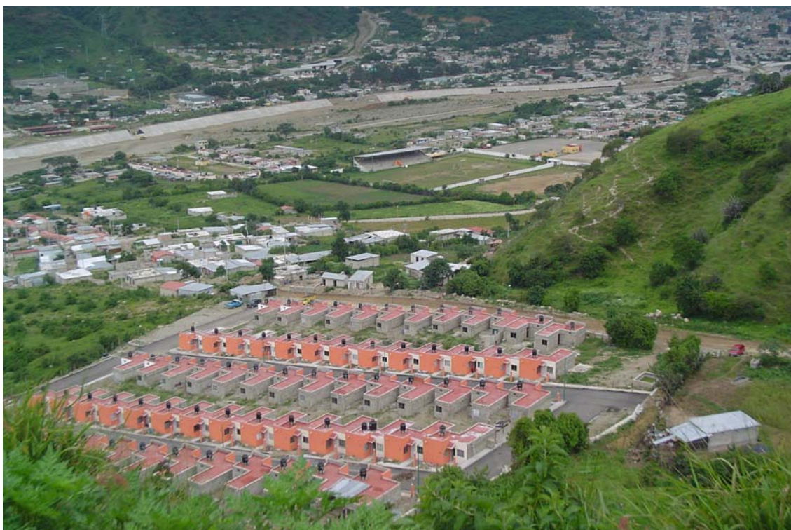
Fig. 3.6 El fraccionamiento fue edificado al pie de una cañada; en la temporada de lluvias, el agua discurre por una de las calles de la colonia hacia el río Xelajú. Fotografía: CRED, delegación regional Motozintla-Sierra.
