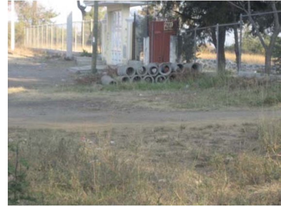
Foto (3) Próxima instalación de red sanitaria
