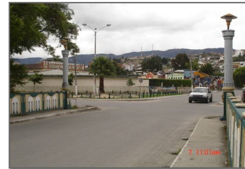
Puente vehicular con tratamiento de hormigón, típico del periodo municipal anterior. Fuente: Archivo del Autor. Fecha: Nov. /2007
