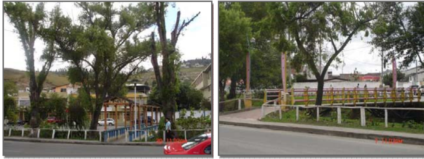
Puentes peatonales con diseños diferentes en los extremos del tramo de río. Izq. Tradicional (calle 10 de agosto). Der. Puente moderno (Inst. Técnico). Fuente: Archivo del Autor. Fecha: Nov. /2006.
