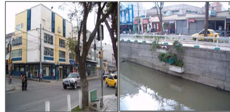
Edificios comerciales en el tramo del río Malacatos. Fuente: Archivo del autor. Fecha: Noviembre/2007
