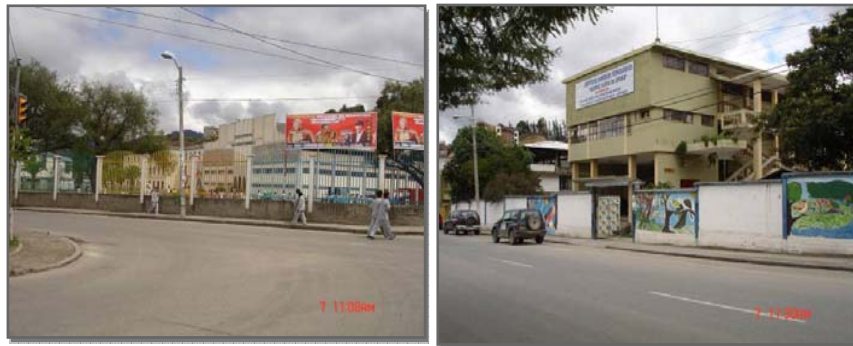
Izq. Instituto Daniel Álvarez. Der. Colegio Beatriz Cueva de A. Eje con tendencia de uso de educación. Av. Orillas del Zamora. Fuente: Archivo del Autor. Fecha: Nov. /2007
