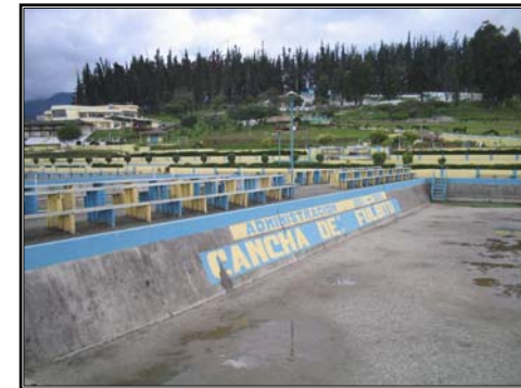
Cancha de índor fútbol, antes uno de los tanques reservorios de agua. Fuente: Archivo del autor (mayo 2007)
