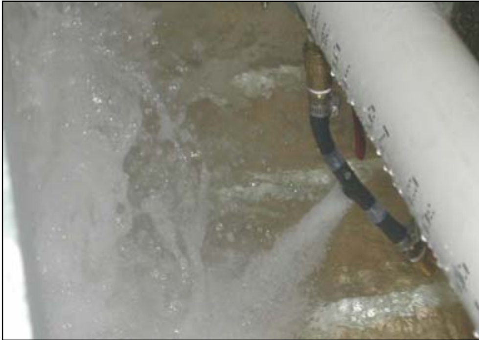
Figura II.17. Espécimen tipo conduit durante el ensayo a 38 mca
