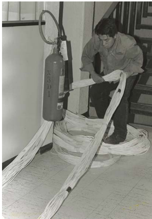
Cableado de instalaciones en el IMP
