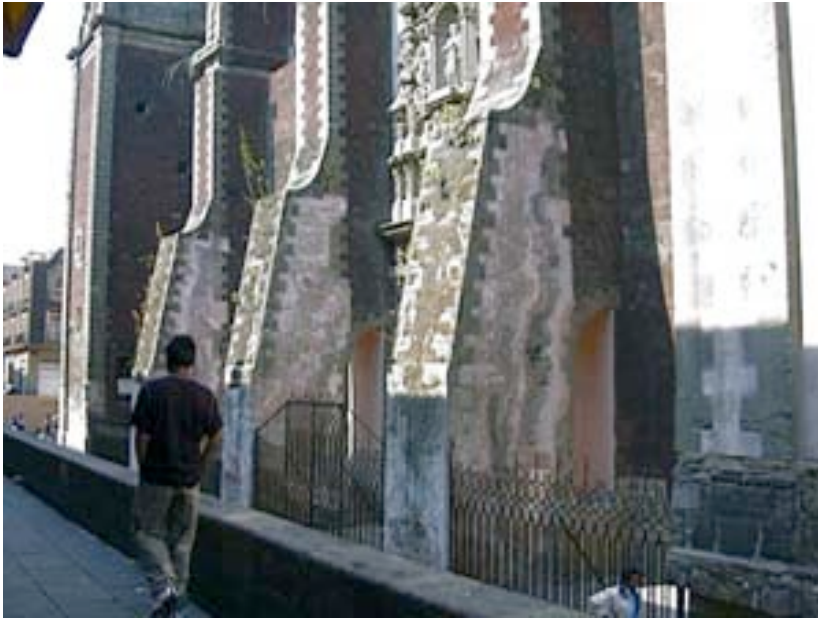
Contrafuertes Iglesia Santísima desde Emiliano Zapata
