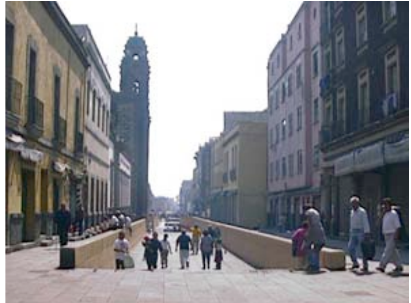
Desnivel en Cerrada de Santísima
