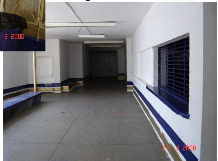
Bodegas de utilería
