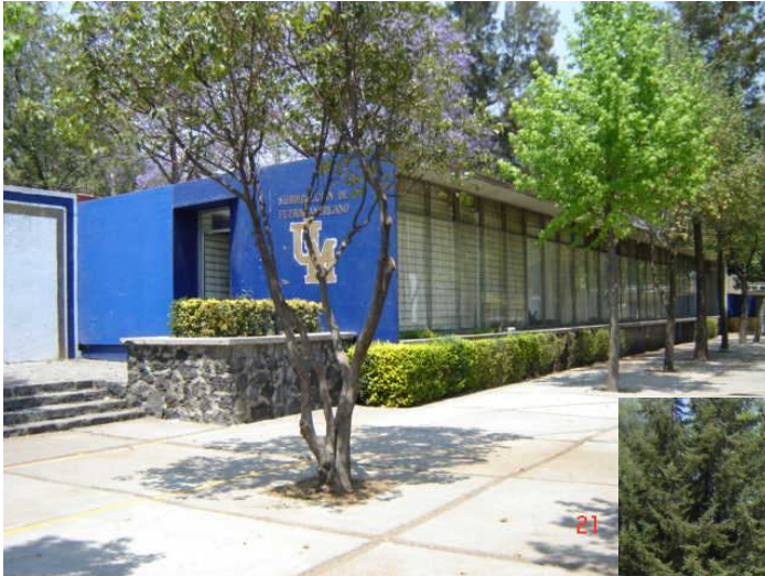
Entrada principal oficinas FBA
