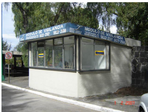
Modulo de vigilancia sobre avenida insurgentes
