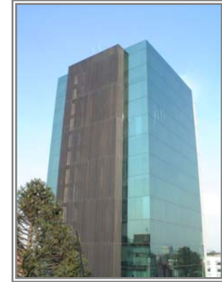
4) Colindancia Edificio de La Judicatura Federal
