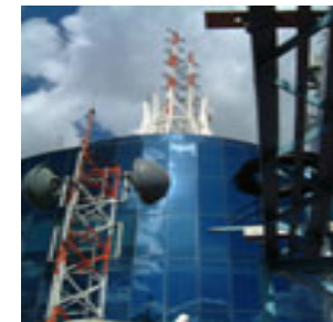
Restaurante y antenas
