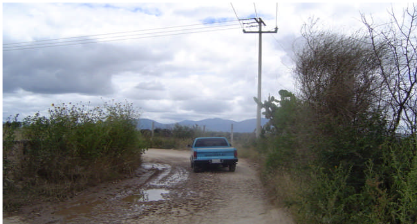
Foto 7 Se pueden observar la red de energía eléctrica que pasa a un lado del terreno.
