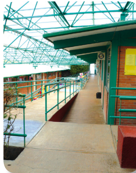
Instalaciones de Comunidad Down
