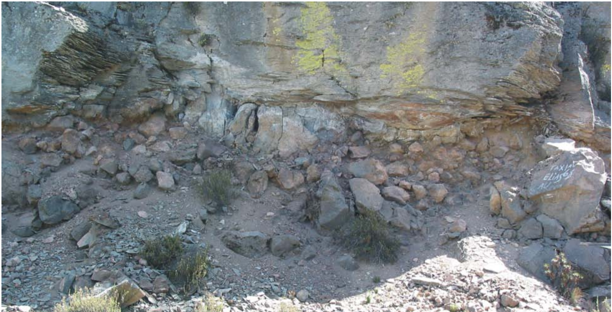
Figura V.1 Discontinuidades conformadas por brechas y/o material granular debajo de los depósitos de lava masivos que funcionan como discontinuidades estructurales.
