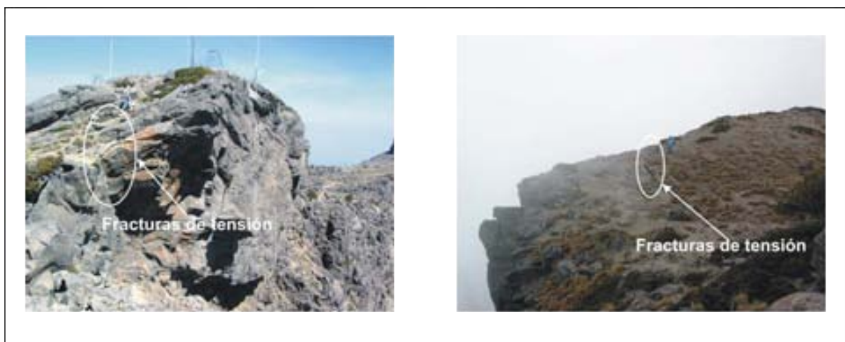
Figura VII.15 Fracturamiento de tensión en las orillas de los escarpes
