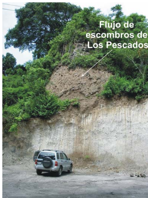
Figura V.10 Flujo de escombros de Los Pescados sobreyaciendo a un depósito antiguo de ignimbritas de origen no determinado
