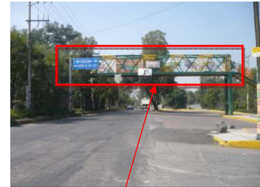
IMAGEN 24: SOBRE LA AVENIDA LOS ANUNCIOS Y PROPAGANDAS POLÍTICAS DETERIORAN EL PAISAJE NATURAL DE LA ZONA.
