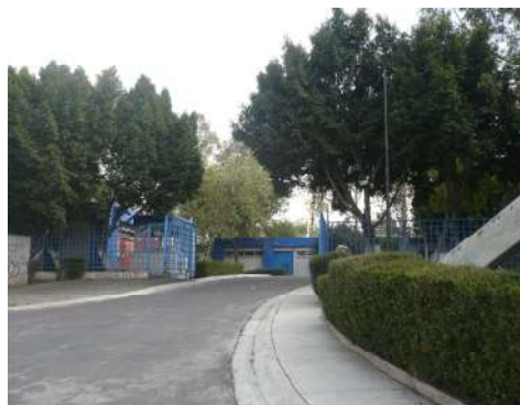
IMAGEN 17: PLANTA DE TRATAMIENTO DE AGUAS RESIDUALES
