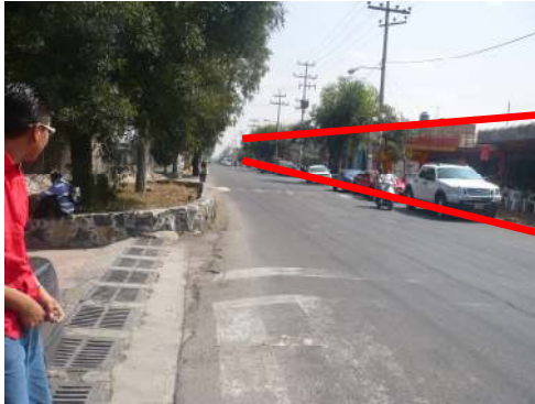
IMAGEN 13: VISTA DEL PERFIL HORIZONTAL DE LA AVENIDA.
