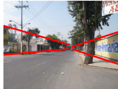
IMAGEN 23 LOS "DIABLITOS" SON OTRO CONTAMINANTE VISUAL, ADEMÁS DE ALTERAR LA RED ELÉCTRICA. TAMBIÉN SE OBSERVA EL PERFIL HORIZONTAL QUE PREVALECE EN LA ZONA.
