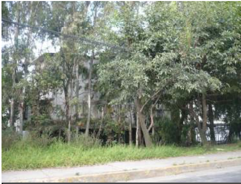
IMAGEN 28: VISTA DE LA CONSTRUCCIÓN ABANDONADA.
