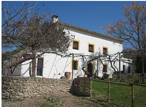
FACHADA PRINCIPAL DEL EDIFICIO
