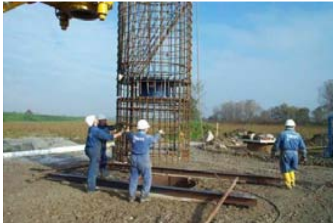
Figura 3.9 “Acero de Refuerzo de un Pila”
