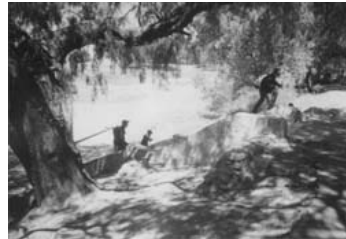
12. ESCALERAS QUE COMUNICAN AL TERRENO CON CAMINO
