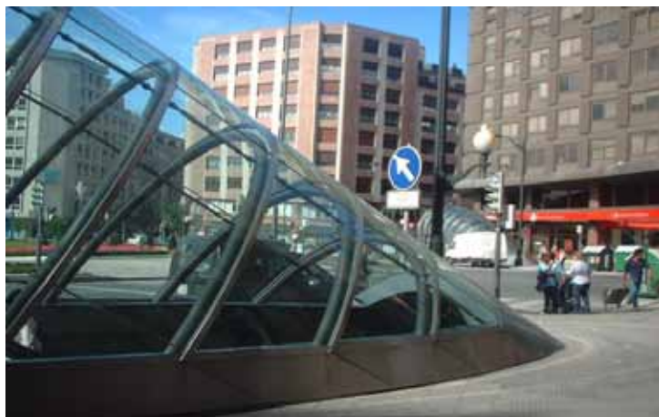
Fig.25 Barrio del Centro Histórico de la Ciudad de Bilbao, España.
