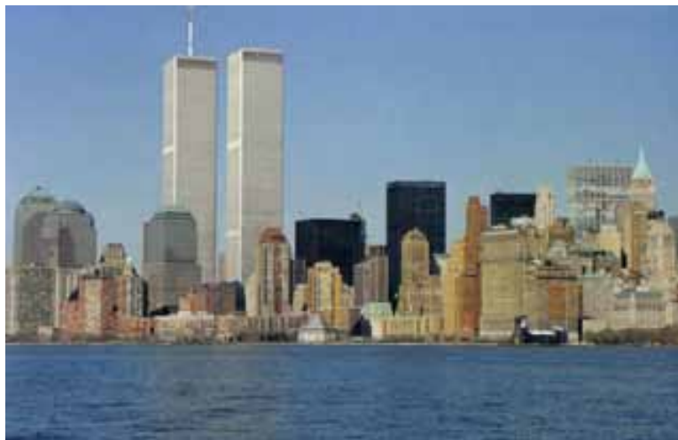
Fig. 74 Vista panorámica de Battery Park, New York.
