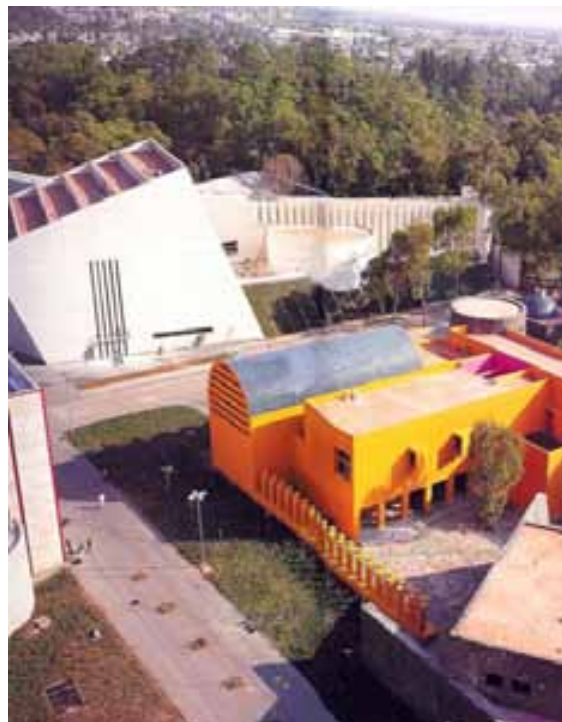
Fig. 41 Área norte de la Macroplaza, Monterrey, México.
