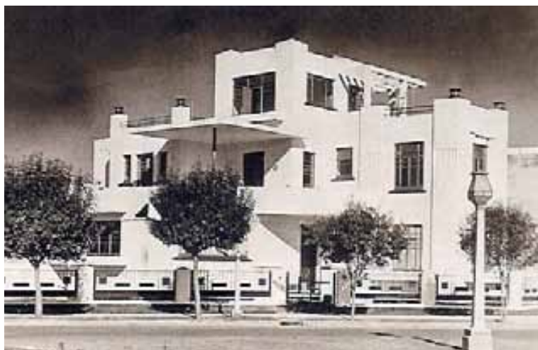
Fig. 14 Vivienda en la Colonia Hipódromo
