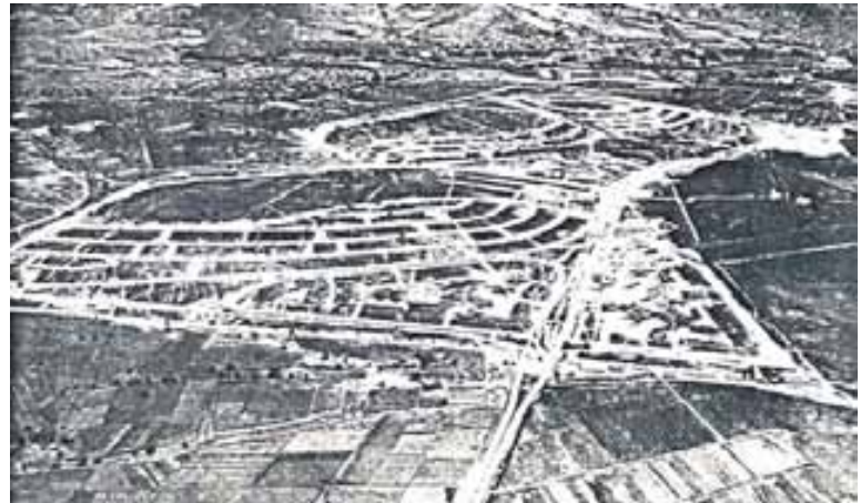
Fig.43 y 44 Fraccionamiento y conjunto habitacional Ciudad Satélite, 1957.
