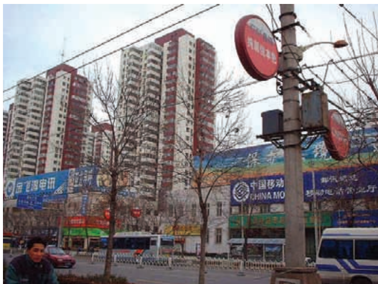
Fig.2 Conjunto de edificios de departamentos, ciudad de Beijing, China.
