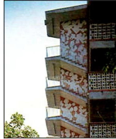
Detalle de las escaleras
