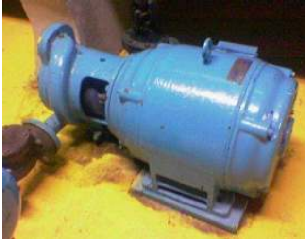
Ilustración 42 hidroneumático bomba
