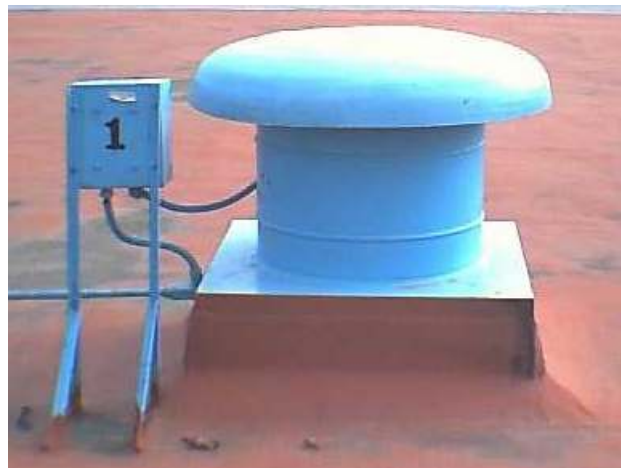
Ilustración 37 Ventilador axial tipo hongo
