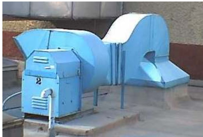
Ilustración 39 Extractor centrífugo
