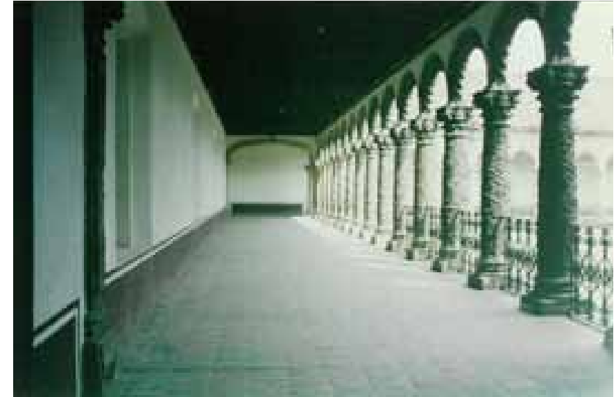
Vista de uno de los pasillos en planta alta. Se aprecia la arcada, el barandal y parte de la techumbre.
