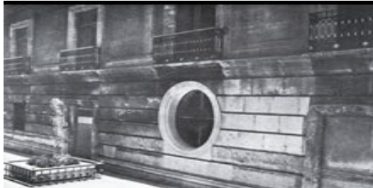
Fachada que da a la calle de la Condesa, una vez restituido el nivel original.
