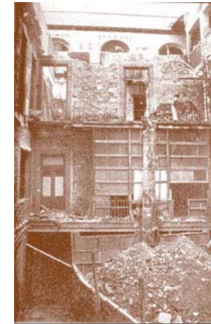
Demolición de obras posteriores al proyecto original.
