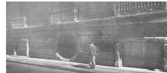
Vista del Palacio de Minería desde el Callejón de la Condesa con el nivel que tenía antes de la restauración.
