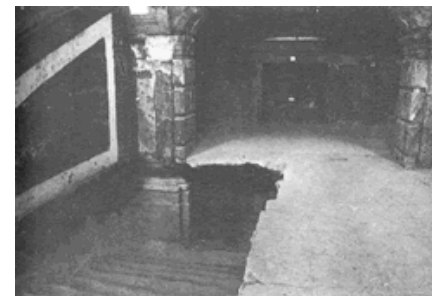
Recuperación del nivel original del piso.
