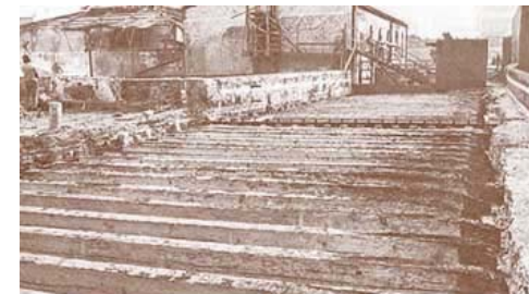
Sustitución de la azotea.
