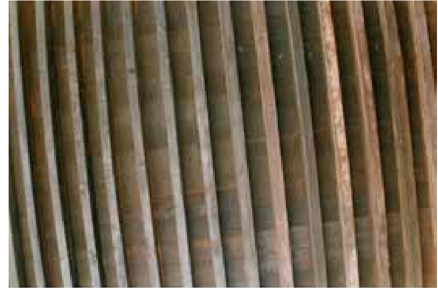
Detalle de la techumbre en los pasillos de planta baja. Este tabla terrado no es original sino de alguna de las intervenciones al inmueble.
