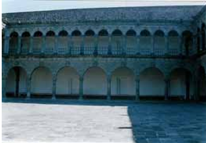
Fachada este del claustro en la que se ven las arcadas y la parte superior del muro colindante con la plaza García Bravo.
