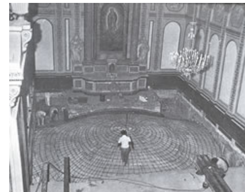
Reposición del piso de la Antigua Capilla
