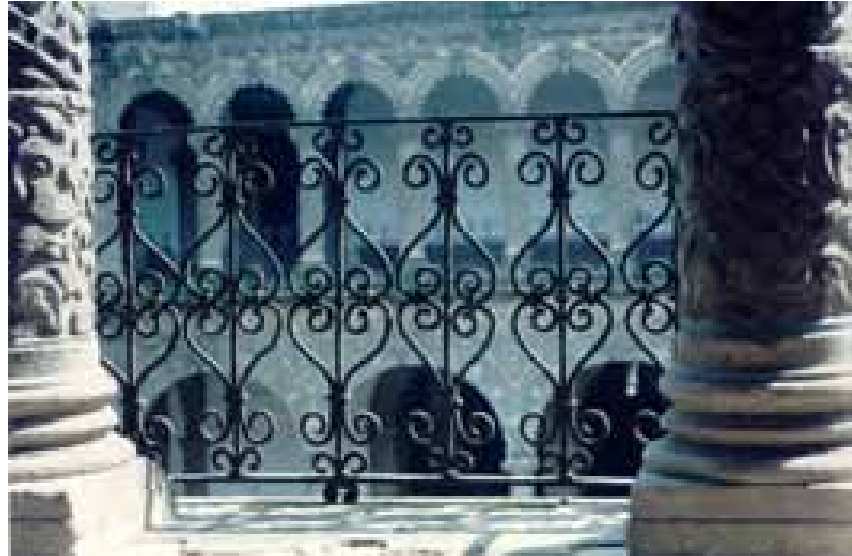
Detalle del barandal de hierro que antes pertenecía al edificio de la antigua Universidad, que fue demolido en 1910.
