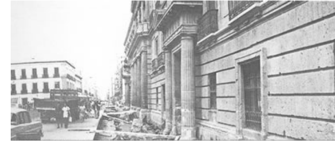
Aspecto de la calle de Tacuba durante las obras de restauración.
