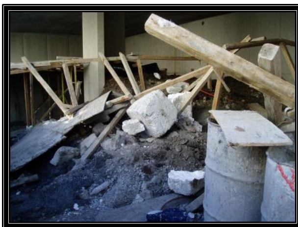
Figura 5.7. Residuos en obras de remodelación Fuente: Elaborada por la autora
