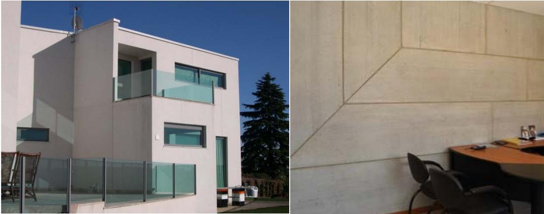
Fuente: muros con placas de fibrocemento<sup>15</sup>
