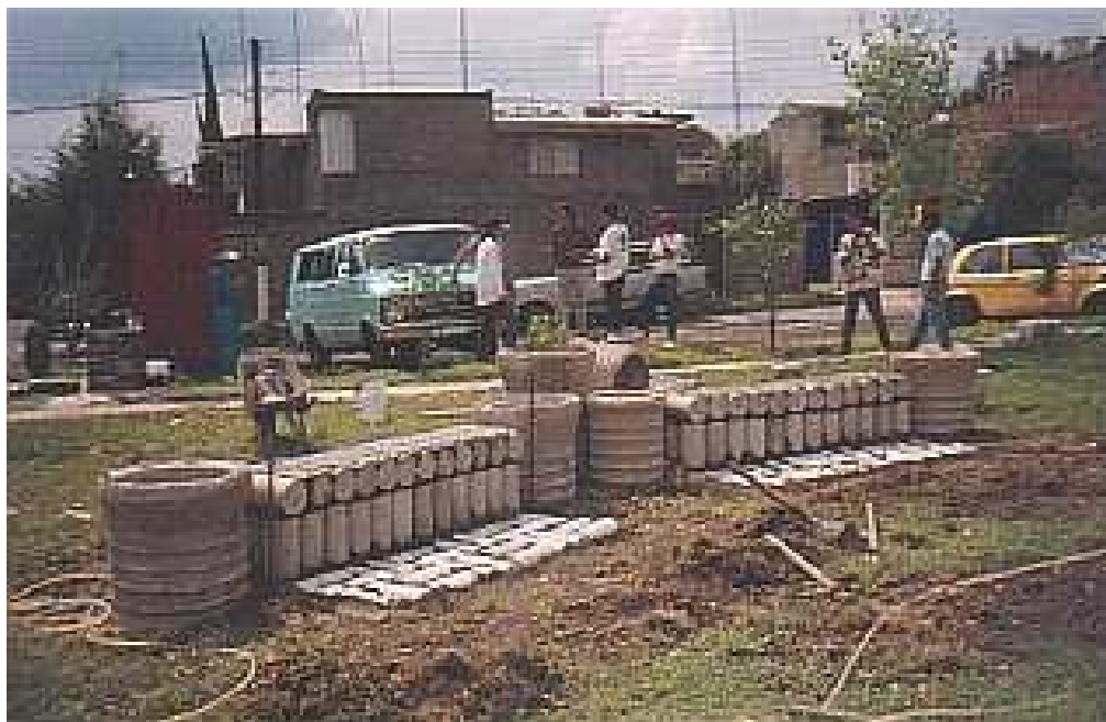
739.- Construcción de bancas con cilindros de pruebas de concreto y tubos de drenaje.
