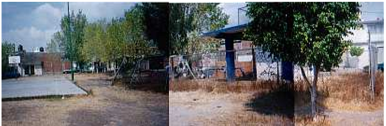
752.- Vista del lado sur del parque. A la derecha edificación del pozo de agua.
