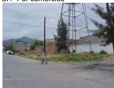
39.- Por instalaciones hidráulicas urbanas
