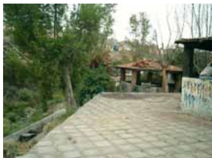
22.- Sin mantenimiento y con acciones destructivas de los usuarios
