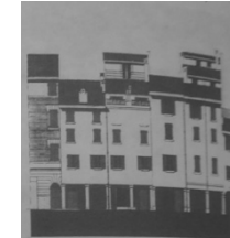
Alzado sobre la calle falcone estado inicial
