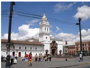
Cableado aéreo de la Plaza
