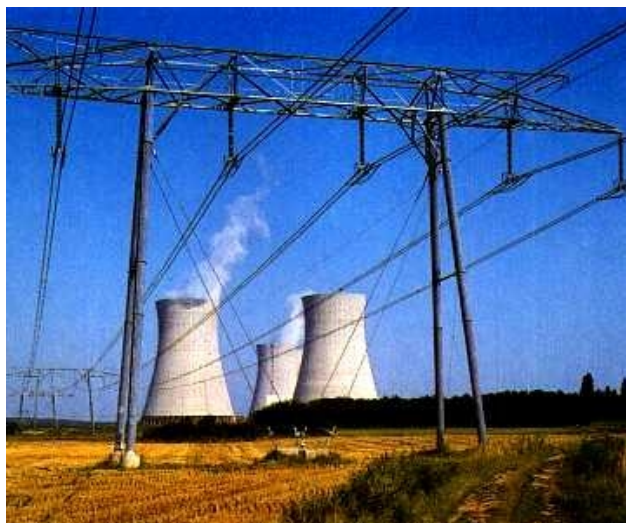
Figura 1.6 Fotografía de una central nuclear con torres de enfriamiento y una línea de transmisión [4]
