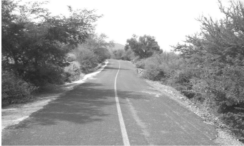
FOTO 01: Estado físico actual del tramo carretero Cuponcillo – La Peña.
