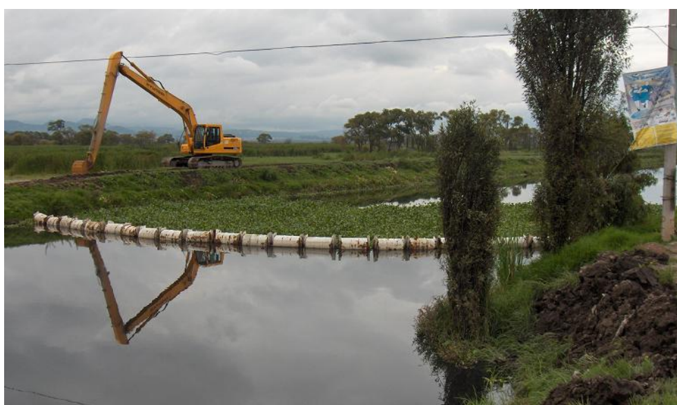
Figura 3.20 Dragado de canales.
