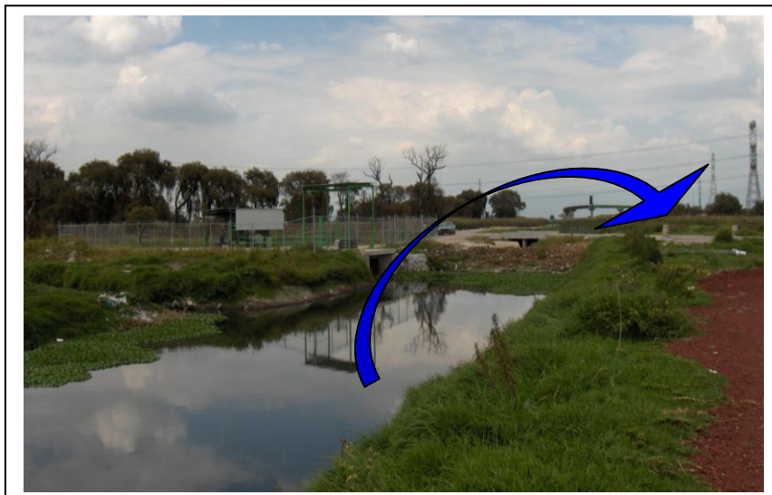
Figura 3.19 Sistema de bombeo de aguas negras municipales al río Lerma.
