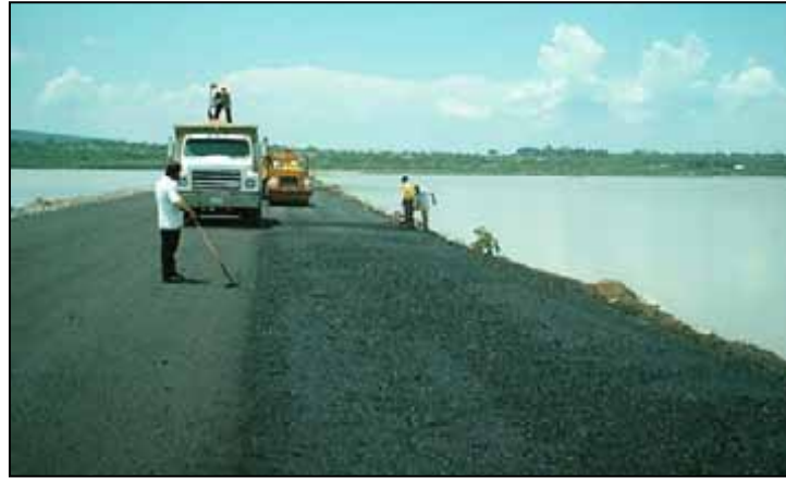
Foto 5.- Construcción de carpeta de concreto asfáltico.
