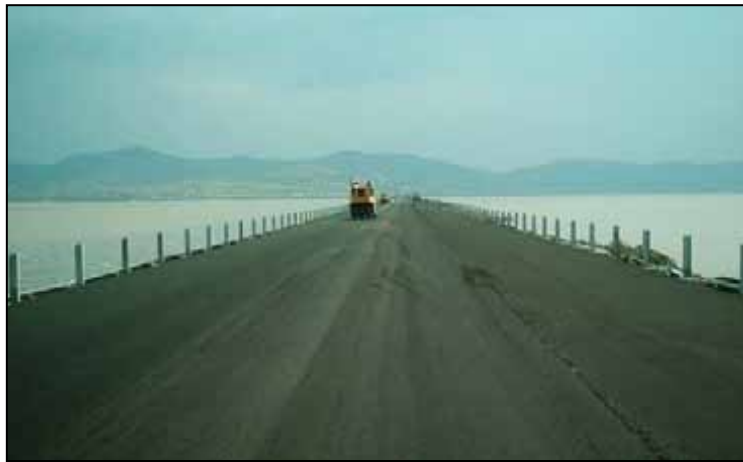
Foto 6.- Compactación de carpeta de concreto asfáltico.
