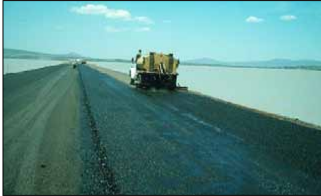
Foto 3.- Riego de impregnación.
