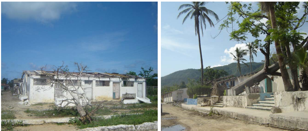
Figura 2.21 Desprendimiento de arboles por acción del viento
