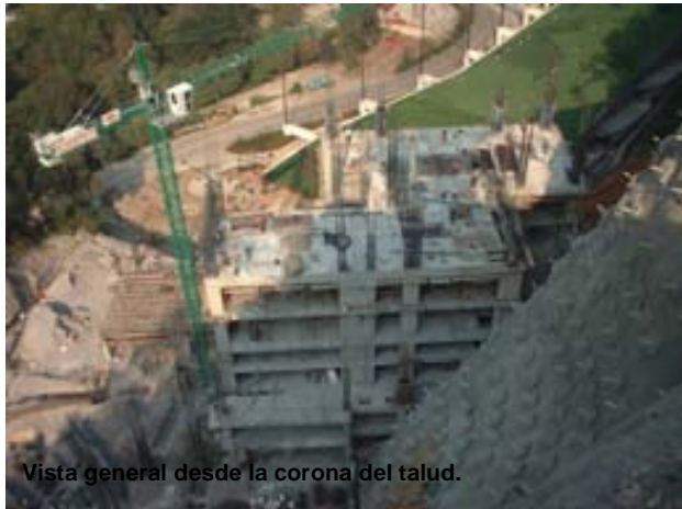
Vista general del frente de la torre “A”, en donde apreciamos claramente la estructuración a base de columnas, traveses postensados, y losa postensada.
