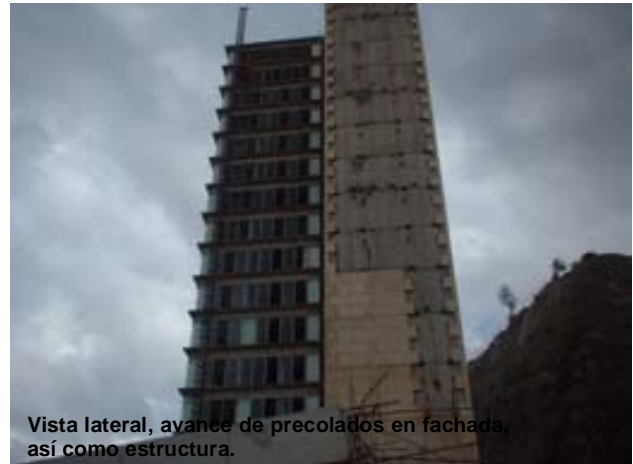
Zona posterior del edificio, en la cual tendremos las recamaras y zona de servicios. Además se aprecian precolados ya colocados en los diferentes niveles.
