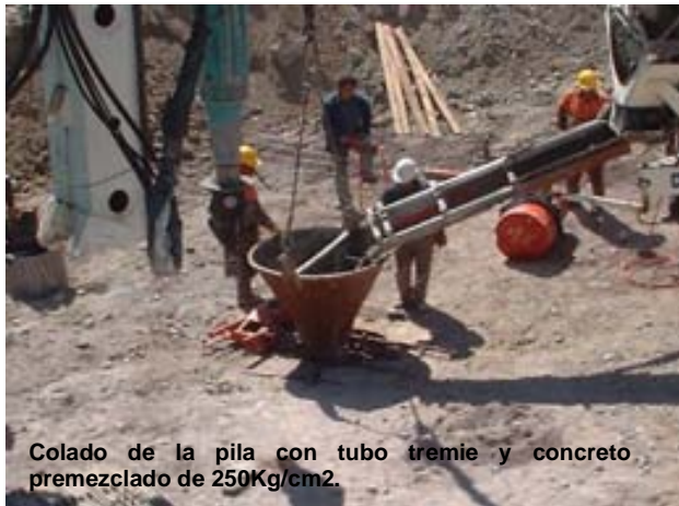
Se inician los preparativos para el colado de la pila con la colocación del ademe que servirá de guía y apoyo para la colocación del tubo tremie.
