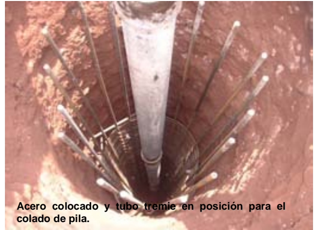
Se inician los preparativos para el colado de la pila con la colocación del ademe que servirá de guía y apoyo para la colocación del tubo tremie.
