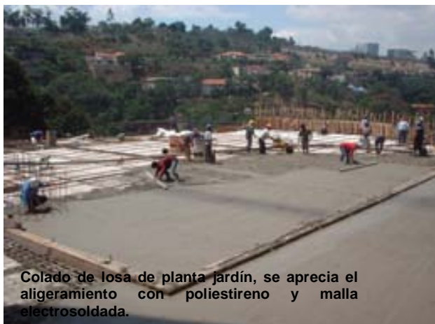
Colado de losa de nivel de terraza, a un lado del departamento Pent Garden.
