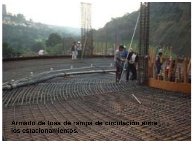
Losas de N-7.40 (motor Lobby). Zona de habilitado de acero para dados y columnas de estacionamiento de Torre “B”, columnas, losa y travesaños de Torre “A”.
