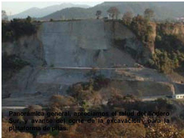
Actividades de retiro de material producto de la excavación, para la plataforma de las pilas. Corresponde al primer tramo de 3mts. de altura.
