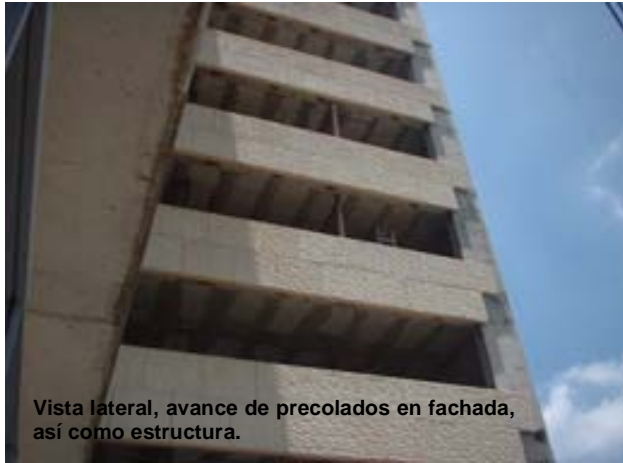
Zona posterior del edificio, en la cual tendremos las recamaras y zona de servicios. Además se aprecian precolados ya colocados en los diferentes niveles.
