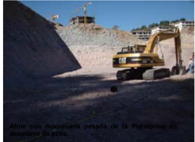
Actividades de retiro de material producto de la excavación, para la plataforma de las pilas. Corresponde al primer tramo de 3mts. de altura.
