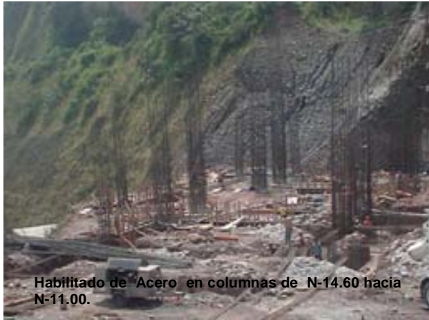
Columnas totalmente armadas y listas para cimbrar.
