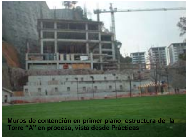
Vista lateral, donde se aprecia la estructuración a base de columnas, muros de concreto lanzado y losas postensadas.
