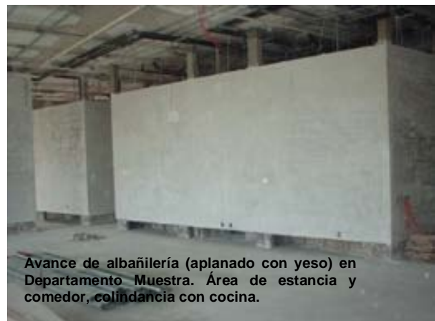
Albañilería de zona de cocina y pantry. En esta fachada se remata con precolados.
