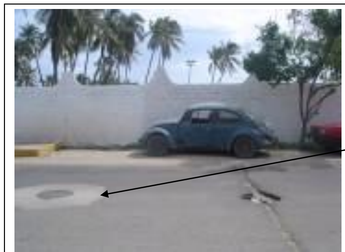
Foto 21. Sistema de Drenaje
