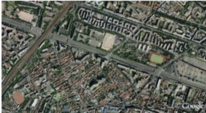
Figura 37: Foto aerea de la puerta de Châtillon
