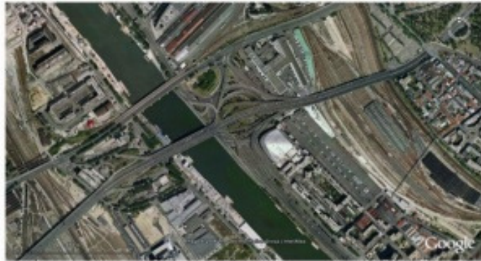
Figura 36: Foto aerea de la puerta de Bercy
